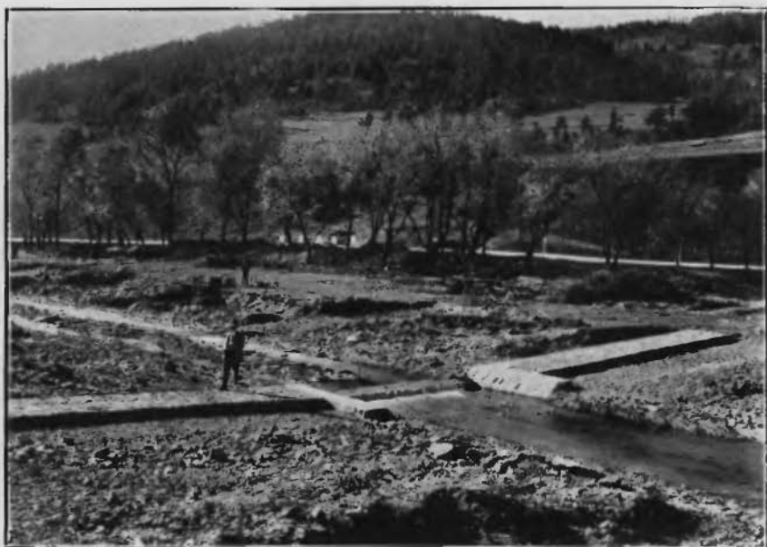
Ryc. 71. Próg kamienny i poprzeczki siatkowo-żwirowe na potoku Florynce. (Na poprzeczce siatkowo-żwirowej stoi kierownik budowy inż. Milan).
