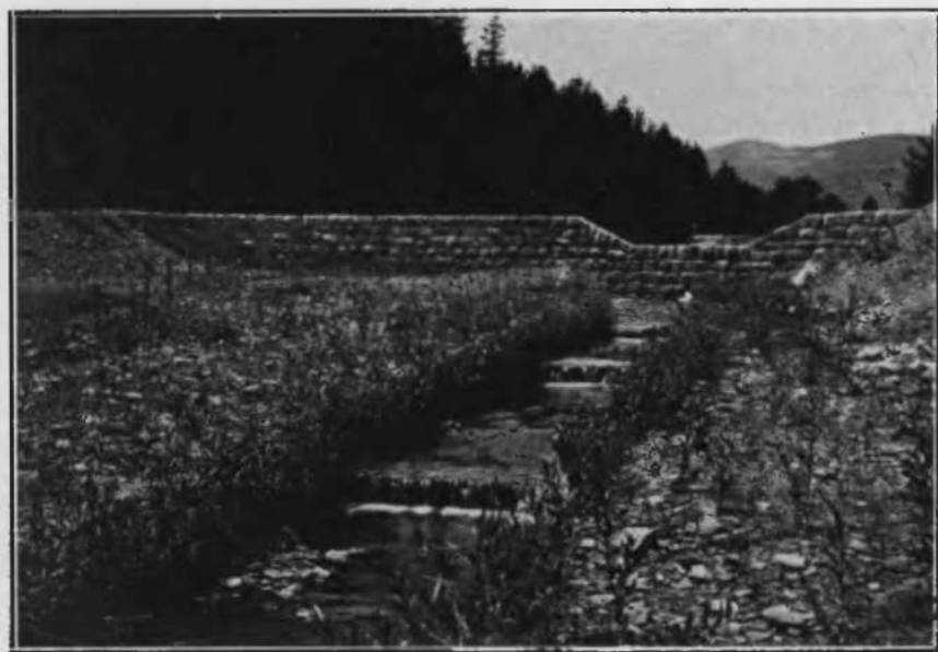
Ryc. 50. Regulacja potoku Bystry (progi kamienne) i zapora kamienna wykonane w r. 1914.
