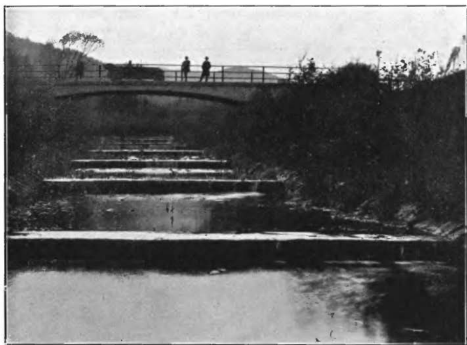
Ryc. 21. Korekcja ujścia potoku Binczarowy do Białej. (W głębi most na drodze państwowej Grybów-Krynica).
