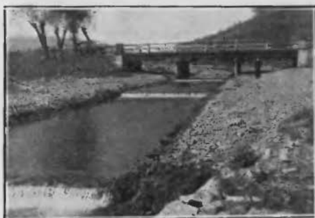
Ryc. 52. Regulacja Ponikiewki (progi siatkowo-żwirowe)
