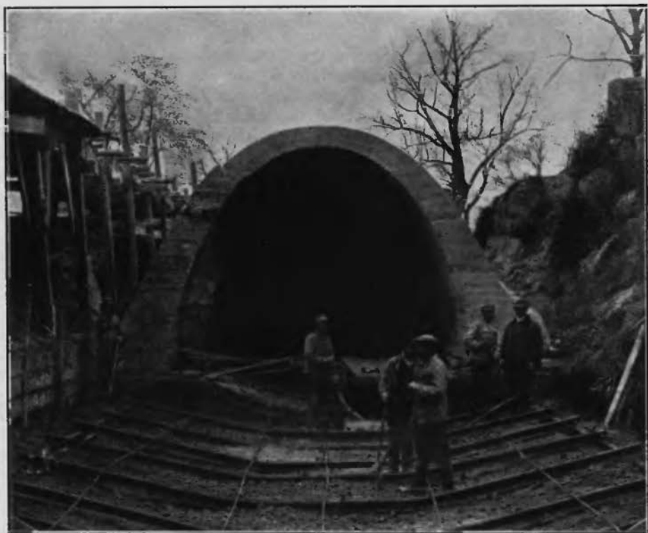
Ryc. 87. Budowa fundamentu zasklepionej Peltwi.
