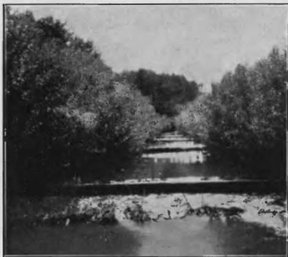
Ryc. 78. Korekcja progowa Dylągówki w Sielnicy.
