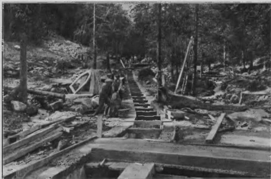
Ryc. 45. Betonowanie dolnej części galerii zbiorczej.
