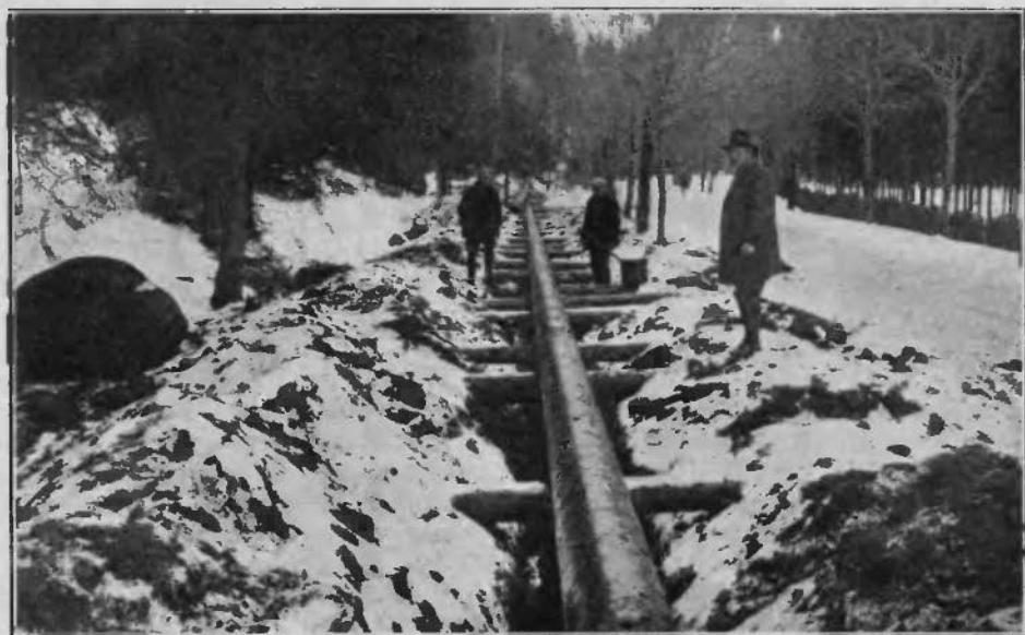
Ryc. 53. Widok rurociągu przygotowanego do spuszczenia na dno rowu.
