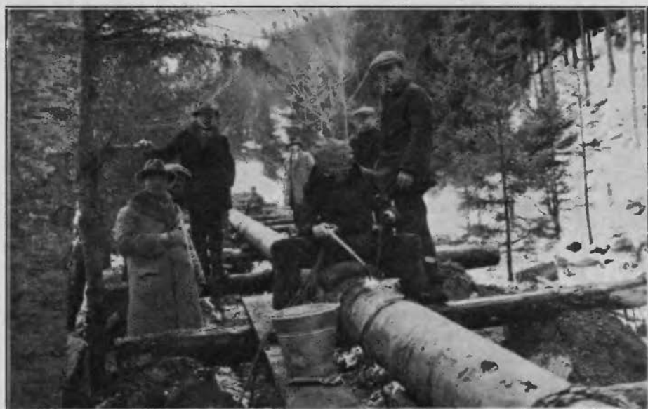
Ryc. 52. Widok spawania rur.
