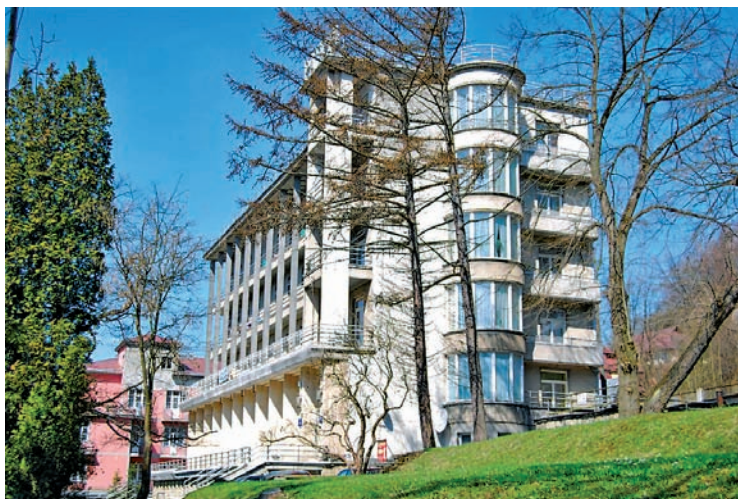
Fot. 5 Przykład najcenniejszego zabytku z okresu 20-lecia międzywojennego w Polsce, sanatorium Patria w Kryńcy, proj. Bohdan Pniewski, 1933, nie wpisane do rejestru zabytków i nie chronione, także nie uwzględniane w dotychczasowych waloryzacjach.
