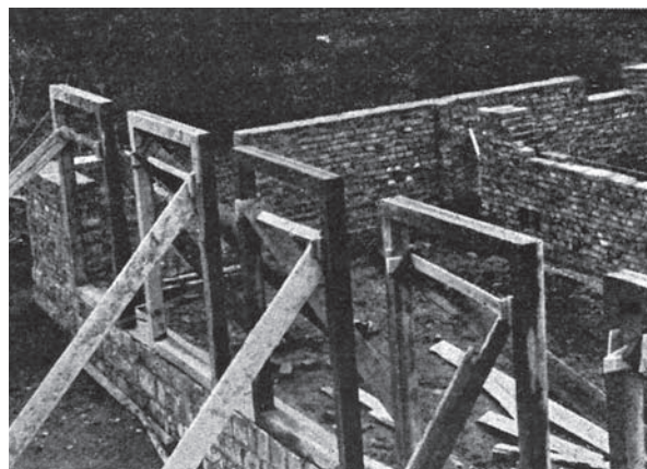
Abb. 1. Fenstergewände-Rahmen, Baustelle Kindergarten in Zwickau-Planitz, 1952, Arch.: Heinrich Rettig (Foto aus Heinrich Rettig: Baukunst und Massenfertigung, Leipzig 1954, S. 13)
