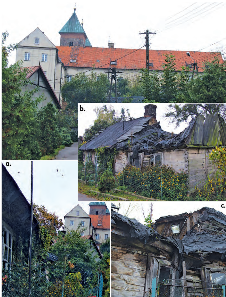
Fot. 3. Czerwińsk. Stare miasto klasztorne. Ulica ku Wiśle. (a) Z lewej strony: narożny, zabytkowy budynek drewniany w konstrukcji zrębowej kryty pierwotnie gontem. Pozbawiony pomocy konserwatorskiej, osiągnął dziś stan unicestwienia (b,c). Fot. autorka, październik 2009
