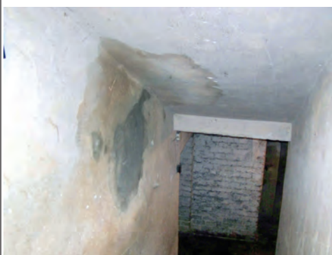
Fot. 9. Zawilgocenie ściany i stropu piwnic
