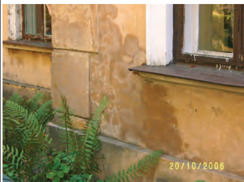
Fot. 4. Zawilgocenie powierzchniowe tynków naroża budynku na skutek obecności soli higroskopijnych
