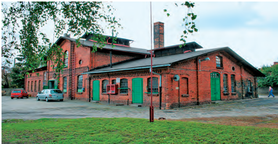
Fot. 3. Gazownia w Śmigł, z prawej widoczne skażenie muru smołą pogazową (czarny fragment elewacji)
