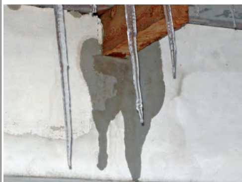
Fot. 1. Przewilgocenia na styku muru i elementu konstrukcji drewniane.
