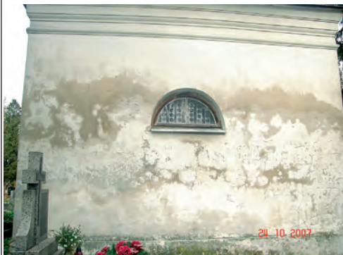
Fot. 3. Maksymalna wysokość podciągania kapilarnego wyznaczona występowaniem soli
