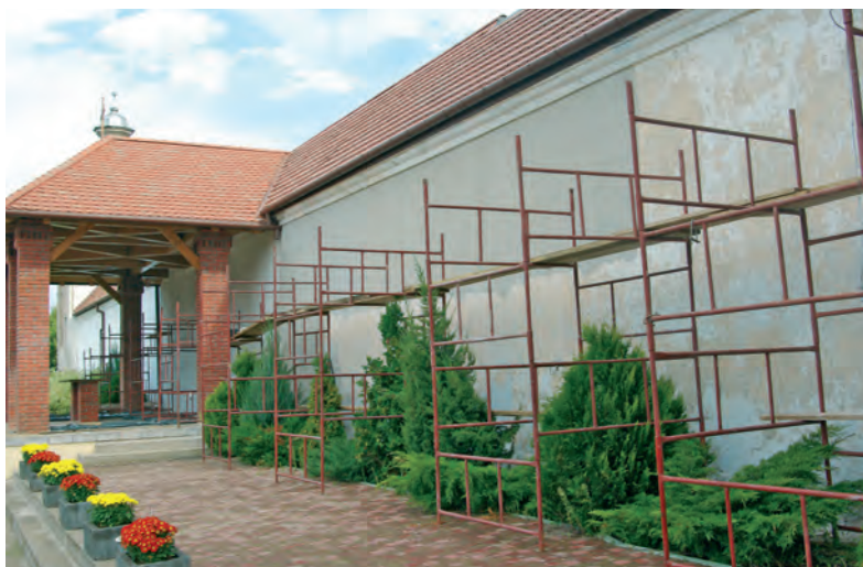
Fot. 17 Zabytkowa ściana XVIII-wiecznego krużganku zaczęła stwarzać problemy, gdy obiekt zawilgocono. Malowanie wapnem hydratyzowanym, nakładanym nieumiejętnie dawało efekty krótkotrwałe. Dziś natomiast oskrobanie z warstw wtórnych, zaprzepaściło całe bogactwo informacji o historii zabytku. Widoczna na fotografii pierwotna kolorystyka miała zostać zarejestrowana i przebadana. Zalecone przez WKZ naprawy ubytków tynku i doraźne pokrycie całości pobiałą wapienną przerosły jednak umiejętności wykonawców prac. Byli oni wyłącznie w stanie zasmarować całość warstwą nowego tynku, niszcząc nieodwracalnie pierwotne opracowanie, zmieniając charakter zabytkowej budowli, narażając właściciela na znacznie wyższe koszty. Prace wykonano tak, że nie ma żadnych szans na trwałość. Fot. T. Łękawa-Wysłouch.
