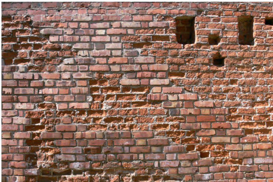
Fot. 8 Nowa cegła użyta podczas prac w latach 80. uległa zniszczeniu z powodu złej jakości, stara z powodu zbyt małej porowatości nowej cegły. Fot. B. J. Rouba
