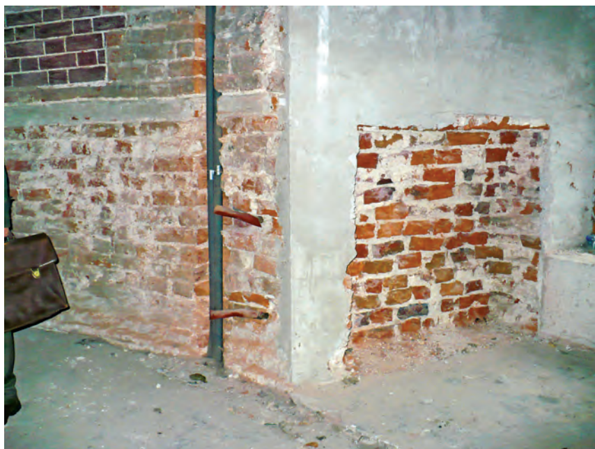
Fot. 4 Przykład dostosowywania zabytku do „wymogów współczesnego życia” – wnękę pod kaloryfer wyrąbano w cegle XV-wiecznej wieży obronnej. Dziś już ani nie ma tamtej instalacji, ani argumentów przekonujących, że pokaleczenie gotyckich murów było do czegośkolwiek potrzebne. Dziś natomiast zagrożeniem jest koncepcja urządzenia w wieży jacuzzi w ramach adaptacji zabytku na hotel. Fot. B. J. Rouba
