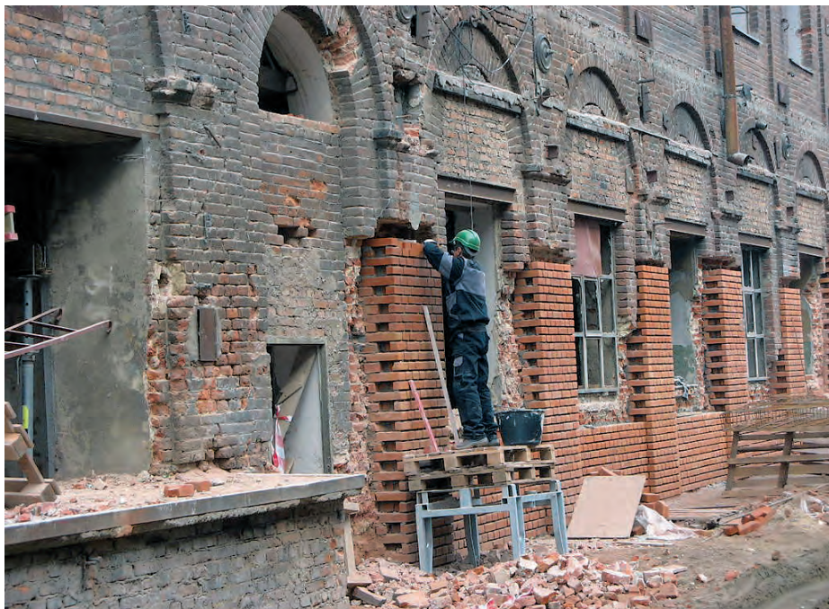
Fot. 3. Wymiana warstw licowych – adaptacja przędzalni Scheiblera w Łodzi do funkcji mieszkaniowych. Fot. P. Molski
