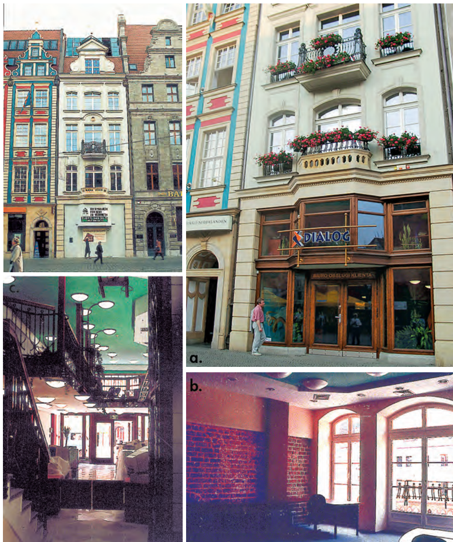
Fot. 5. Wrocław, kamienica Rynek nr 35. Elewacja od strony Rynku, etap końcowy prac modernizacyjnych. (a) Konserwatorskie prace wykończeniowe na elewacji z dodaniem nowoprojektowanych elementów zharmonizowanych z zabytkowym charakterem fasady: przeszklonej zabudowy parteru, kutych balustrad w balkonach I i II piętra; (b) We wnętrzach I piętra odsłonięto i wyeksponowano na ścianach wątki gotyckiego muru, poddając je konserwacji zachowawczej i restauracji; (c) Projekt wnętrza parteru z salą obsługi klientów telefonii „Dialog”, opracowano na technologicznej bazie płyt g/k w stylistyce nowoczesnej. [Projekt modernizacji kamienicy: Cel-Art, arch. J. Cempa, Wrocław]. Od 2009 roku w parterze kamienicy funkcjonuje lokal gastronomiczny.
