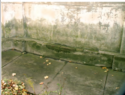
Fot. 6. Obecność glonów spowodowana wysokim zawilgoceniem przyziemia budynku
