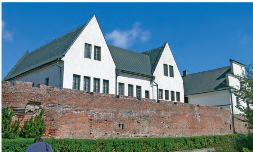
Fot. 7 Muzeum w Koninie – budynek główny w latach 1978-86 nadbudowany na ruinach gotyckiego zamku, zniszczonego od XIX w. W trakcie odbudowy starano się uszanować oryginalną substancję zamku i wyeksponować ją z pietyzmem, ale zlekceważono przy tym zasadę integralności technicznej i kompatybilności materiałów. W rezultacie dziś interwencji wymaga niemal wszystko – sam budynek muzealny, dziedzińce, mury obronne.
