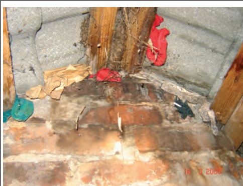
Fot. 7. Przewilgocenia ściany szczytowej budynku.
