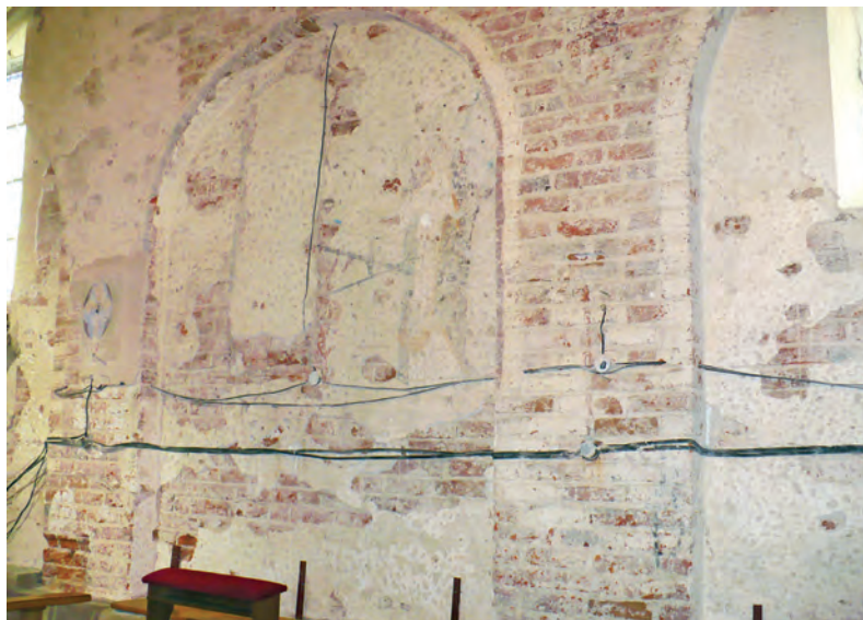
Fot. 5 Dopiero po odsłonięciu gotyckich tynków z malowidłami stało się widoczne ile szkód wyrządzono w niedalekiej przeszłości, podczas prucia ścian pod instalacje elektryczne. Gdyby w zabytkach instalacje wykonywano wyłącznie nawierzchniowo, bez prawa naruszania oryginału nie mielibyśmy tego rodzaju przypadków. Fot. B. J. Rouba
