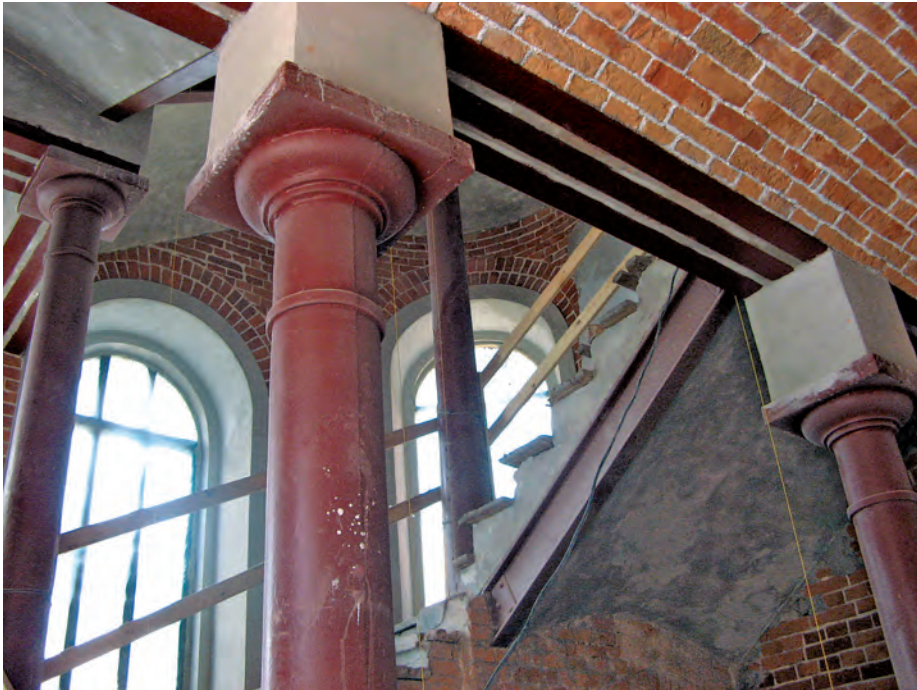
Fot. 5 Głowice słupów wyeksponowane w odrestaurowanej klatce schodowej – Stara prężdzalnia – Żyrardów
