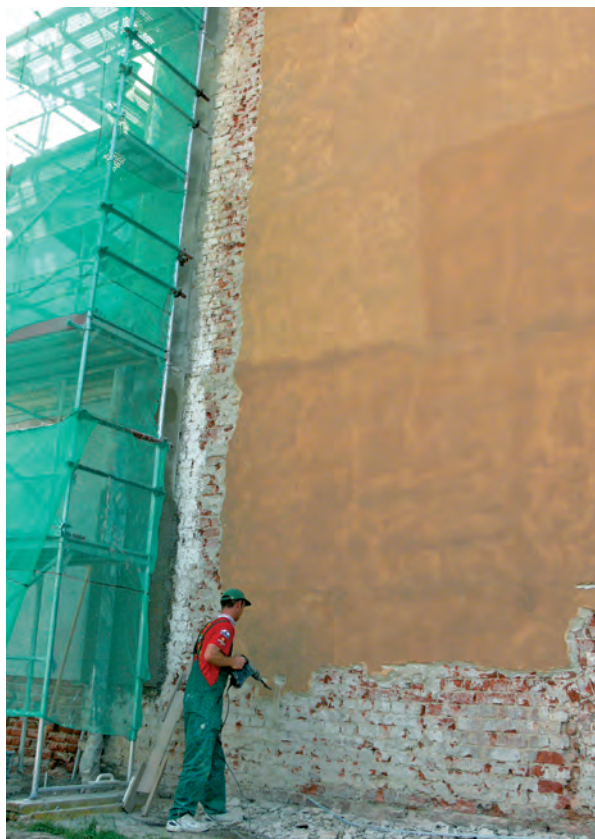
Fot. 12 Maniera wymieniania dobrych tynków na całych fasadach zabytkowych kościołów jest ekonomicznie nieuzasadniona. W takich jak ten przypadkach nie bierze się również pod uwagę faktu, że wtórnie nałożony tynk ma zawsze znacznie słabszą przyczepność do podłoża, niż tynk, który wiązał wraz z zaprawą murarską spajającą cegły. Fot. B. J. Rouba
