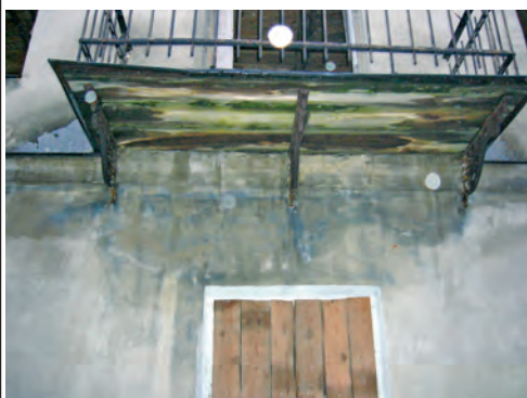
Fot. 2. Zawilgocenie i wysolenia tynków pod płytą balkonową
