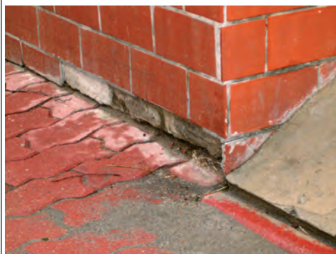
Fot. 5. Nieszczelność styku opaski i ściany.
