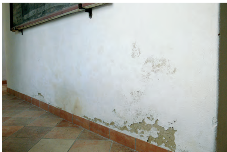
Fot. 15 Tu również po drugiej stronie ściany jest łazienka. Podczas jej użytkowania woda przesącza się w ścianę przez porowate spoiny między kafelkami, natomiast uszczelnienie kafelkami ścian i posadzek wymusza jej odprowadzanie w kierunku korytarza. Rezultatem tych procesów jest niszczenie zachodzące tak szybko, że w zasadzie remont mógłby odbywać się każdego roku. Fot. B. J. Rouba
