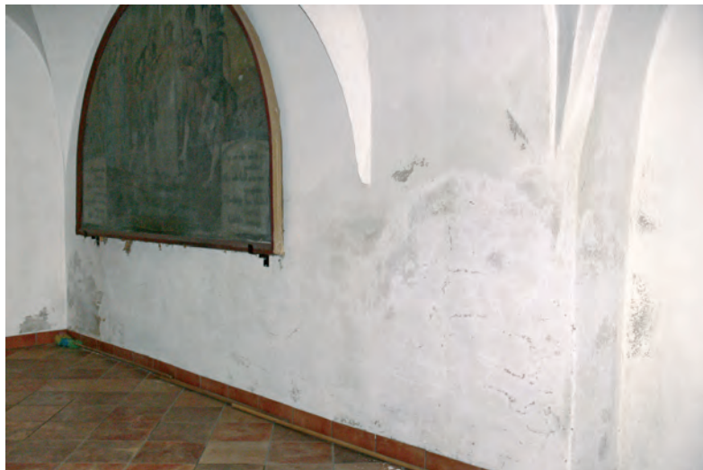
Fot. 14. Po drugiej stronie tej gotyckiej ściany klasztornej znajduje się pomieszczenie, które 12 lat temu zaadaptowano na łazienkę. W 2004 zniszczone tynki zostały wymienione a dziś po pięciu zaledwie latach nadają się ponownie do wymiany. Zniszczenia widoczne po prawej stronie fotografii odpowiadają miejscu, gdzie na pokrytej glazurą ścianie zawieszono są dwie umywalki. Zniszczenia z lewej strony w dolnej części przy narożniku – to miejsce, gdzie znajduje się brodzik i kabina prysznicowa. Fot. B. J. Rouba
