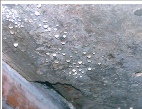
Fot. 8. Kondensacja powierzchniowa pary wodnej
