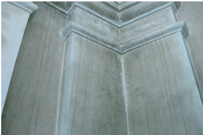
Fot. 3 Fragment ściany kościoła, który od lat 70. zaczęto intensywnie modernizować. Ściany pokryto gipsową szpachlówką i pomalowano farbami tzw. „emulsyjnymi”. W 1974 zamontowano ogrzewanie nawiewowe do tego stopnia destabilizujące klimat kościoła, że w jego wnętrzu bardzo często dochodzi do kondensacji. Skraplająca się woda przez lata płynęła po ścianach strumieniami, prowadząc do ich zagrzybienia. Fot. B. J. Rouba
