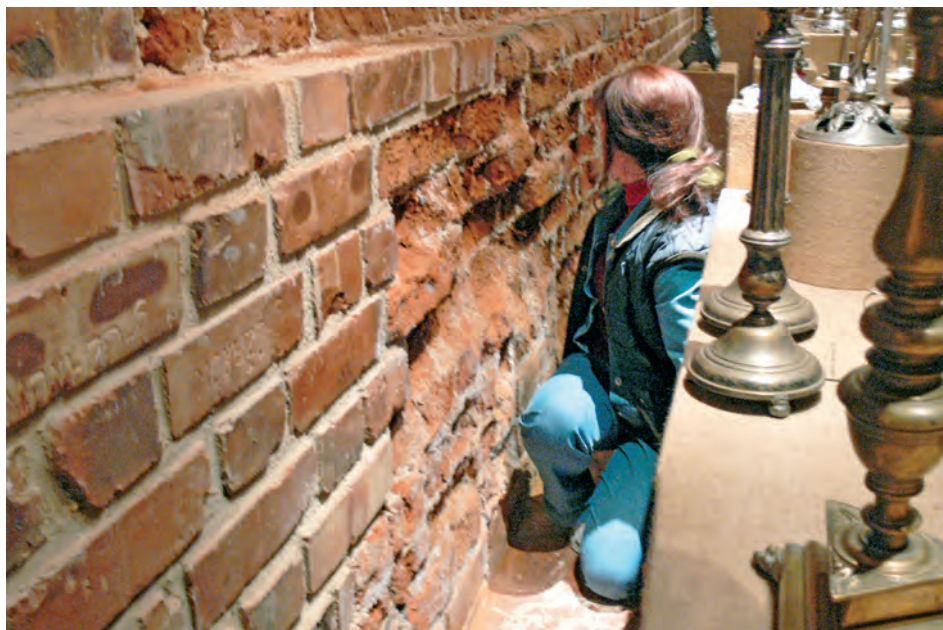
Fot. 9 Dodatki cementu do zaprawy z lat 80., źle dobrana porowatość nowej cegły, zaniedbane pęknięcia ścian, uszczelniony cementem bruk dziedzińca, stan przyziemia budowli, intensywne ogrzewanie i przesuszone powietrze we wnętrzu sprawiły, że stara cegła pełniła rolę sącza, przez który odparowywała woda niosąca ze sobą sole. Stan z kwietnia 2007 roku. Fot. B. J. Rouba
