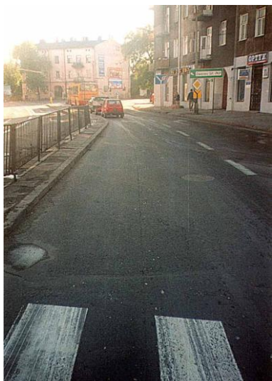
Fot. 3.8. Stan nawierzchni pasa ruchu przed skrzyżowaniem ul. Młyńskiej z ulicą Piłsudskiego po 3 latach eksploatacji – podbudowa i warstwa wiążąca z BAC [6, 30]
