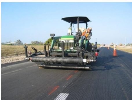
Fot. 5.3. Zbrojenie warstw asfaltowych georusztem Tensar AR-G [50]
