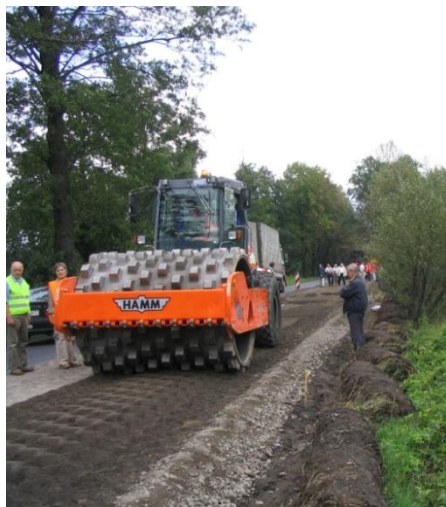
Fot. 3.18. Wykonanie podbudowy „in situ” z mieszanki mineralnej z asfaltem spienionym na DK 50 odc. Strachówka – Łochów.
