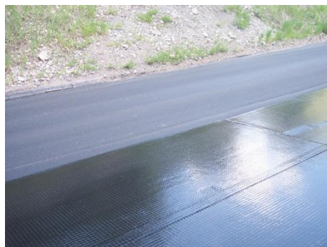
Fot. 5.6. Siatka z nici utworzonej z włókien szklanych pokrytych elastomerem GlassGrid® [50]
