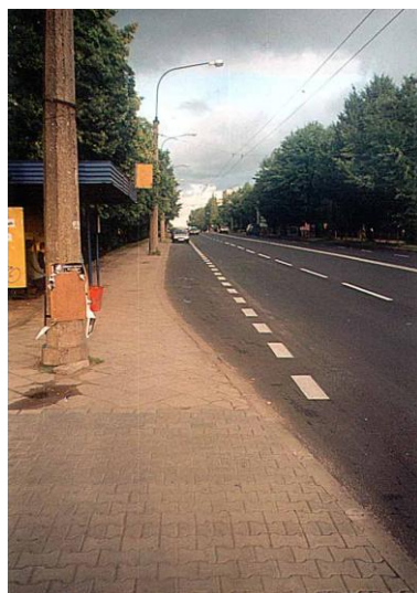
Fot. 3.7. Stan nawierzchni przystanku na ulicy Męczenników Majdanka. BAC (8+8) cm na podbudowie pomocniczej z kruszywa stabilizowanego cementem (h=20 cm) [6, 30]
