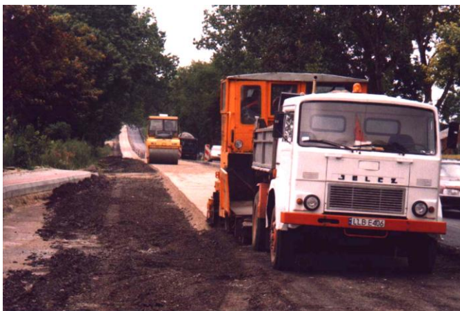
Fot. 3.16. Rozkładanie kruszywa doziarniającego za pomocą rozkładarki do mieszanek mineralno-asfaltowych [36]
