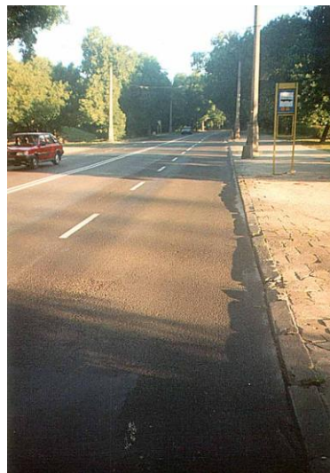
Fot. 3.5. Stan nawierzchni przystanku na ulicy Piłsudskiego o podbudowie i warstwie wiążącej z BAC po 3 latach eksploatacji [6, 30]
