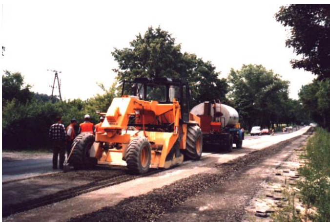
Fot. 3.17. Mieszarka do kruszyw stabilizowanych cementem z zamontowanym systemem dozowania emulsji na drodze nr 12 [36]
