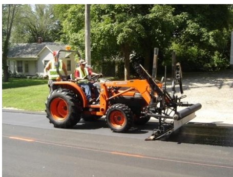
Fot. 5.5. Siatka z włókna szklanego umieszczona pomiędzy warstwami wysokiej jakości tkaniny poliestrowej GlassPave™ [50]
