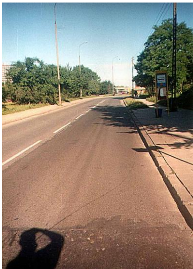
Fot. 3.6. Stan nawierzchni przystanku na ul. Północnej po 3 latach eksploatacji – podbudowa i warstwa wiążąca z BAC [6, 30]
