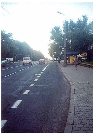
Fot. 3.9. Stan nawierzchni przystanku na drodze Męczenników Majdanka (przed ulicą Lotniczą) po 2 latach eksploatacji. BAC (8+8) cm na podbudowie pomocniczej z bruku kamiennego [6, 30]
