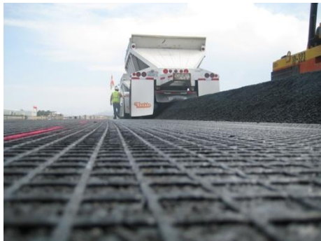
Fot. 5.3. Zbrojenie warstw asfaltowych georusztem Tensar AR-G [50]
