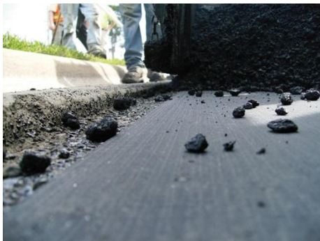
Fot. 5.5. Siatka z włókna szklanego umieszczona pomiędzy warstwami wysokiej jakości tkaniny poliestrowej GlassPave™ [50]
