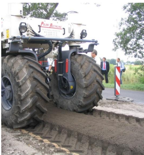
Fot. 3.18. Wykonanie podbudowy „in situ” z mieszanki mineralnej z asfaltem spienionym na DK 50 odc. Strachówka – Łochów.
