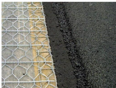
Fot. 5.8. Siatki stalowe do zbrojenia nawierzchni asfaltowych Mesh Track® [46] i Road Mesh® [47] (technologia Bitufor®)
