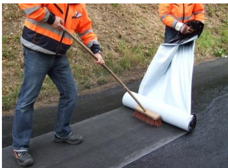
Fot. 5.4. Kompozyt siatki pasów z włókien szklanych połączonych z igłowaną geowłókniną na membranie nasyconej asfaltem GalsstexPatch [50]
