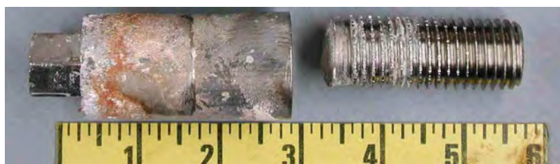
Rys.5. Uszkodzona śruba mocująca mieszadła
