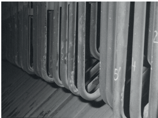
Rys. 6.32. Przegrzewacz pary III- stopnia kotła OP-215 [90].
