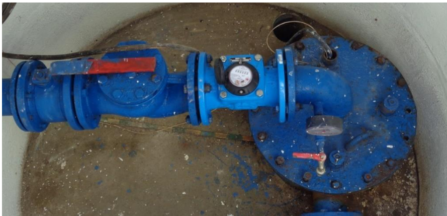
Rys. 5. Przykład niepoprawnego montażu wodomierza – przed klapą zwrotną grzybkową (zdjęcie autora)
