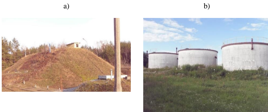
Rys. 6. Fotografie zbiorników pionowych, żelbetowych: (a) zagłębionych w ziemi i (b) posadowionych na powierzchni terenu (fotografie własne)
