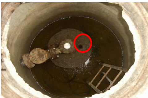
Rys. 3. Fotografie studni w stacjach wodociągowych.: (a) obudowa studni na poziomie terenu, (b) obudowa typu Lange na poziomie terenu, (c) obudowa wyniesiona powyżej terenu, (d) wnętrze studni wypełnione wodą z infiltracji opadów (fotografie własne)
