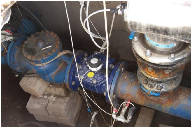
Rys. 4. Przykład niepoprawnego montażu wodomierza – za zmianą kierunku o 90°, przed kłapą zwrotną grzybkową (zdjęcie autora)
