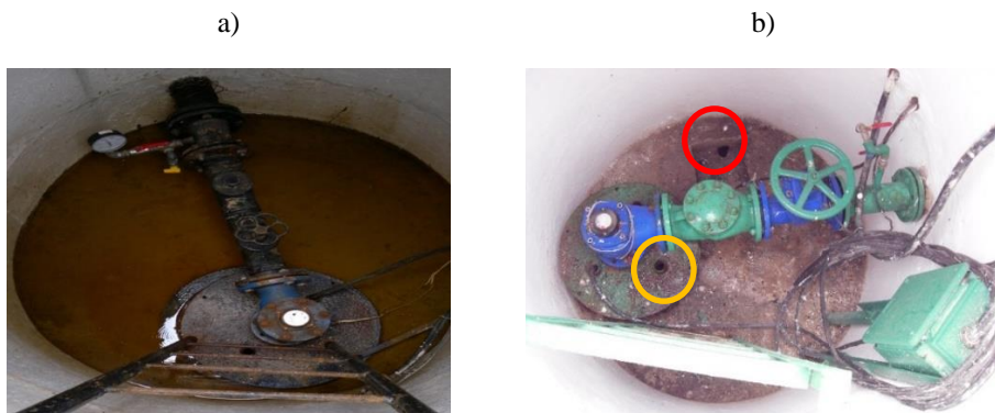
Rys. 4. Pokrywa studni przesunięta względem otworu (a) otwory w pokrywie potencjalne miejsca skażenia wody (b) (fotografie własne)
