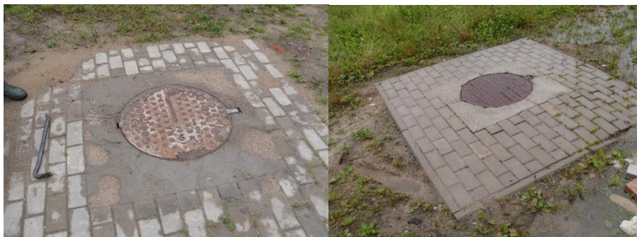
Rys. 10. Podniesienie wjazdu o studzienki – zabezpieczenie przed niewielkim spływem
