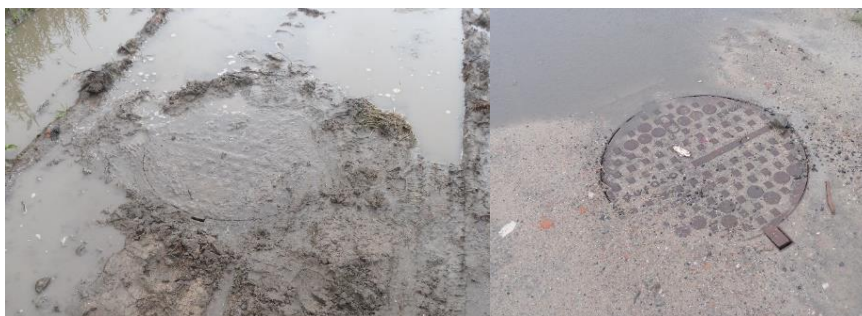
Rys. 9. Nisko zamontowane pokrywy studzienek (fotografia własna)
