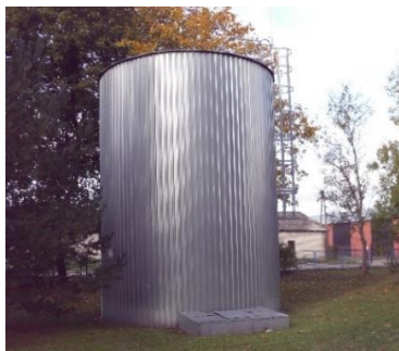
Rys. 5. Fotografie zbiorników pionowych, stalowych posadowionych na powierzchni terenu (fotografie własne)
