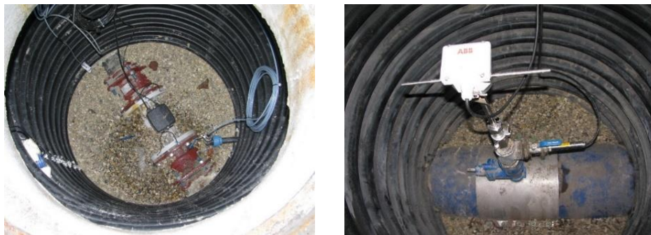
Rys. 11. Przykłady montażu przepływomierzy elektromagnetycznych w komorze: kołnierzewego (zdjęcie po lewej) i sztycowego (zdjęcie po prawej) (Koral., 2012)
