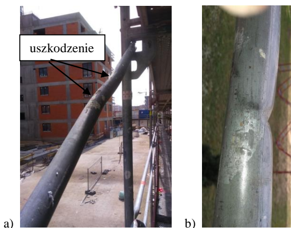
Rys. 3.4. Uszkodzenia stężenia pionowego: a) zakrzywienie osi rury, b) punktowe wgięcie
