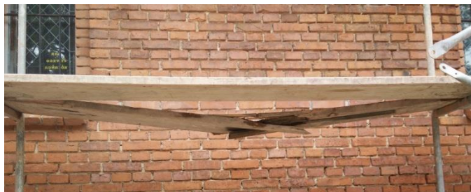
Rys. 3.8. Złamany pomost drewniany
