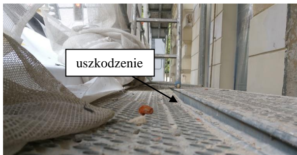
Rys. 3.10. Uszkodzenie pomostu stalowego
