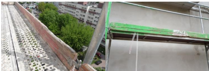
Rys. 3.14. Uszkodzenia krawężników zabezpieczających.
