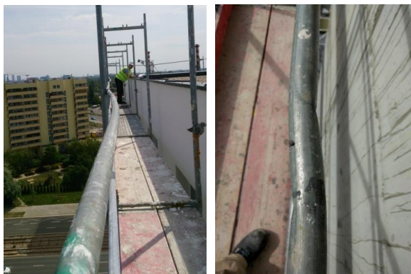
Rys. 3.15. Uszkodzenia poręczy
