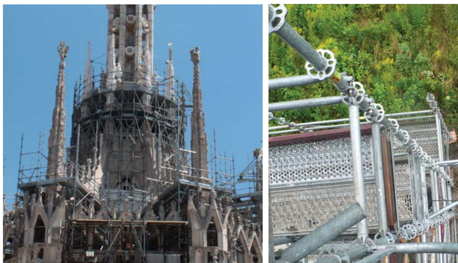
Rys. 2.8. Rusztowanie modułowe [fot. P. Jamińska-Gadomska]
