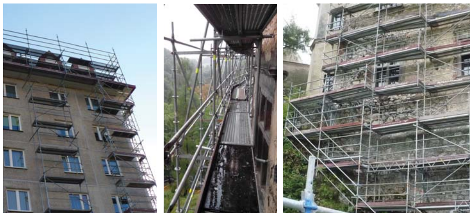
Rys. 2.10. Połączenie rusztowań ramowych i modułowych [fot. P. Jamińska-Gadomska]
