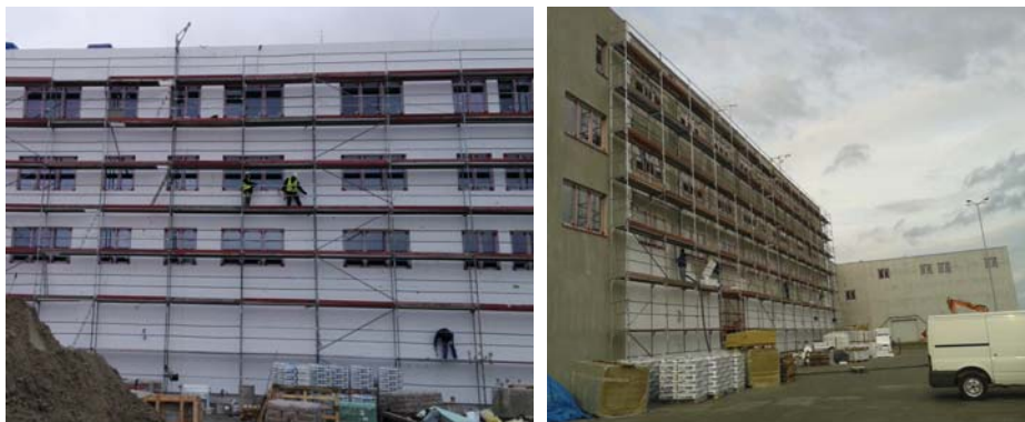
Rys. 8.2. Widok rusztowania P10 ustawionego przy budynku [fot. P. Jamińska-Gadomska]
