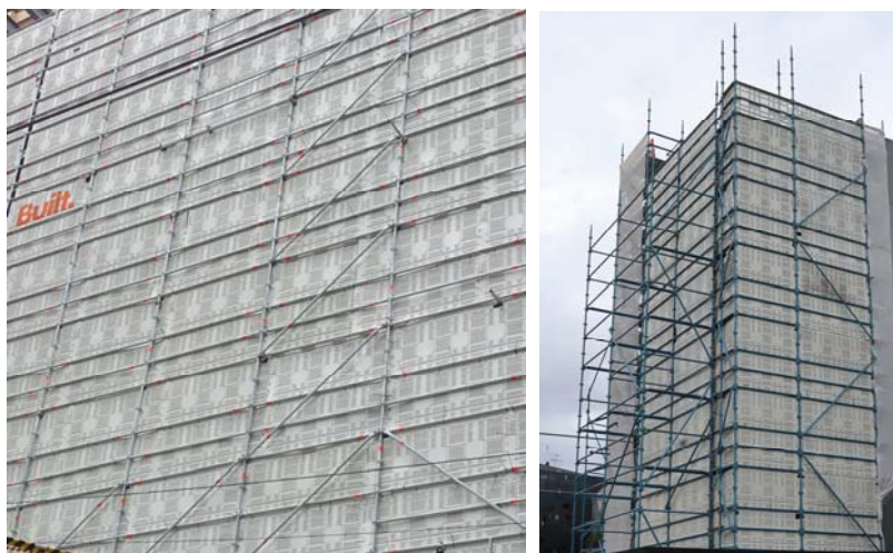
Rys. 2.13. Zabezpieczenie rusztowań w postaci okryć plastikowych [fot. P. Jamińska-Gadomska]
