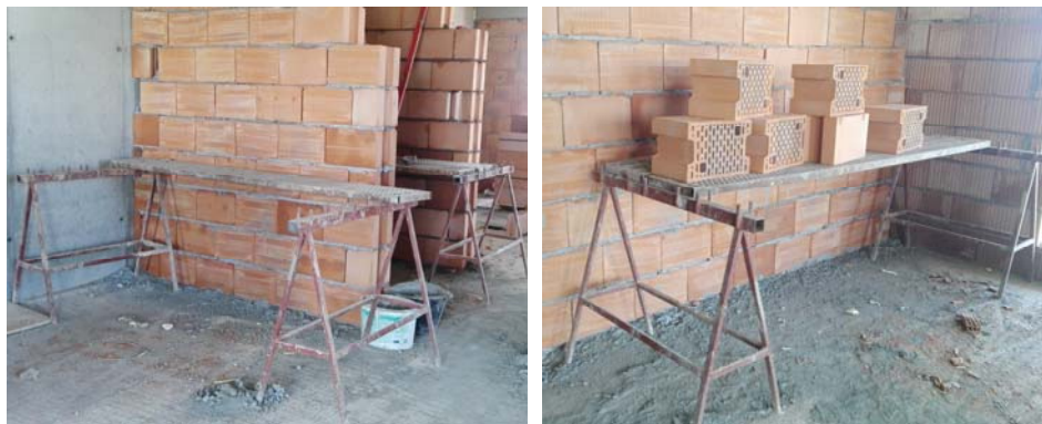
Rys. 2.6. Rusztowanie kozłowe wykorzystane do prac murowych [fot. P. Jamińska-Gadomska]
