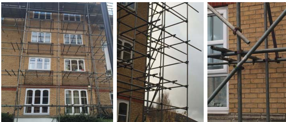
Rys. 2.7. Rusztowanie stojakowo-złączkowe [fot. M. Pieńko]
