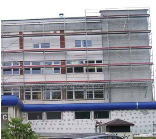
Rys. 2.11. Przykład rusztowania: a) wolnostojącego z odciągami [fot. P. Jamińska-Gadomska], b) podwieszonego na konsolach [fot. E. Błazik-Borowa]
