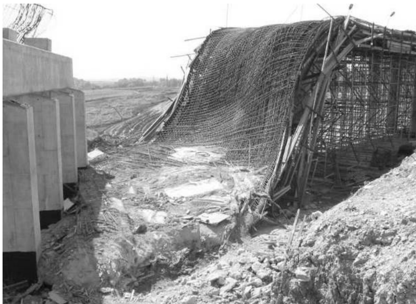
Rys. 2.10 Przykład katastrofy budowlane rusztowań wsporczych w trakcie układania mieszanki betonowej (fot. [25])
