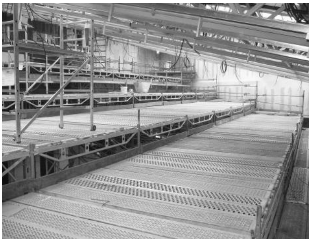
Rys. 1.1 Platforma robocza wykonana z systemu modułowego w trakcie realizacji obiektu „Galeria Zamek” w Lublinie
