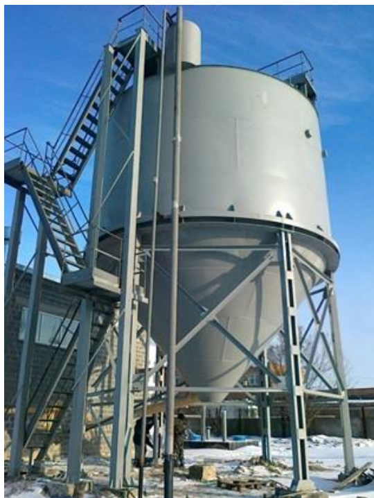
Fig.10. Settler-flotator diametr 7,2 m
