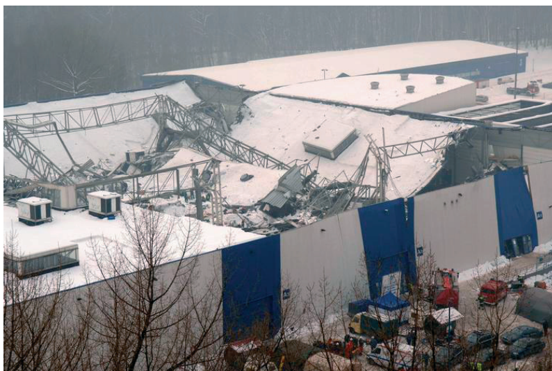
Rys. 3. Katastrofa pawilonu na terenie Międzynarodowych Targów w Katowicach (fot. GUNB)
