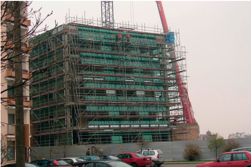
Rys. 8. Rusztowanie podczas budowy Izby Skarbowej w Lublinie
