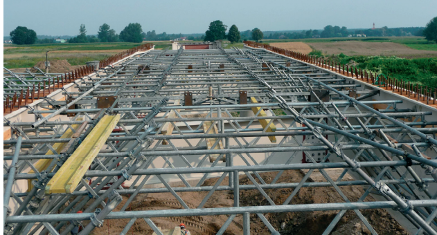
Rys. 4. Konstrukcja wsporcza deskowania płyty mostu przez rzekę Wisłok w Budach Łańcuckich
