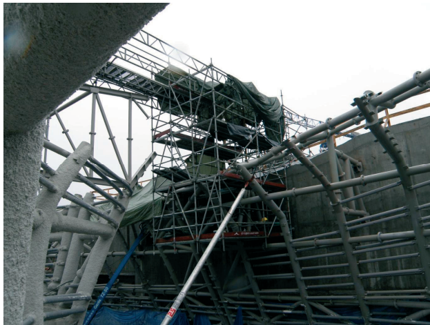
Rys. 3. Rusztowanie modułowe, wykorzystywane do malowania konstrukcji stalowej w Muzeum Historii Żydów Polskich w Warszawie
