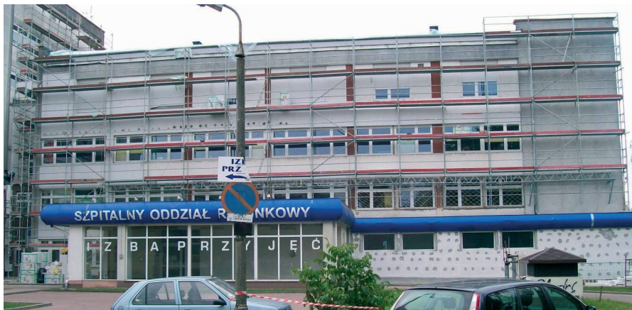
Rys. 5. Rusztowanie na ścianie Szpitala Kolejowego w Lublinie
