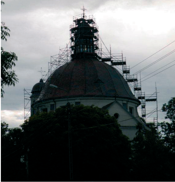
Rys. 2. Rusztowanie modułowe wykorzystywane podczas prac renowacyjnych wieży kościoła parafialnego w Hodyszewie
