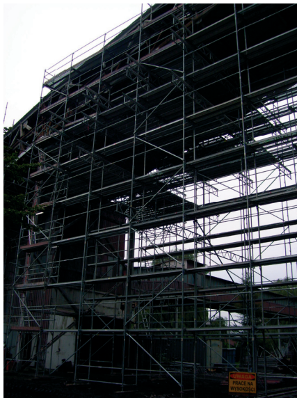
Rys. 6. Platforma robocza do prac remontowych przy moście przekąźnikowym w KWK „Pniówek” w Pawłowicach
