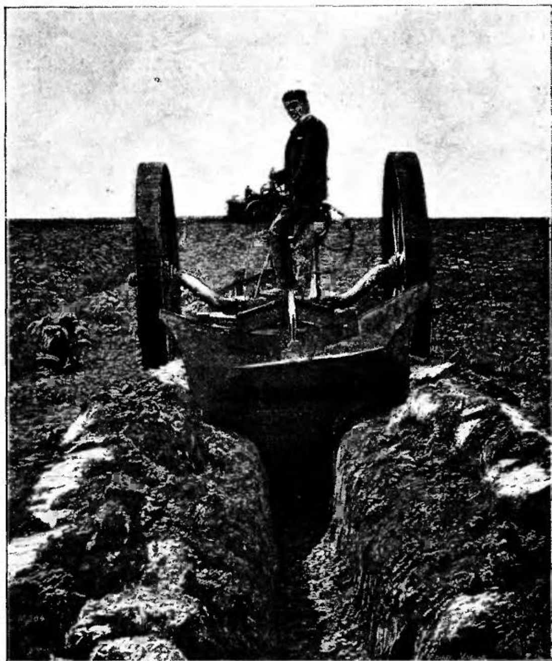
Rys. 45. Wyorywanie rowu 1 mtr. głębokiego za pomocą pługa parowego.
