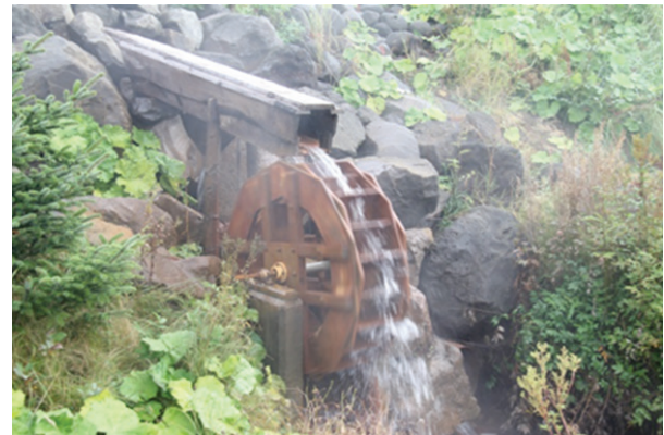
Mała elektrownia wodna
