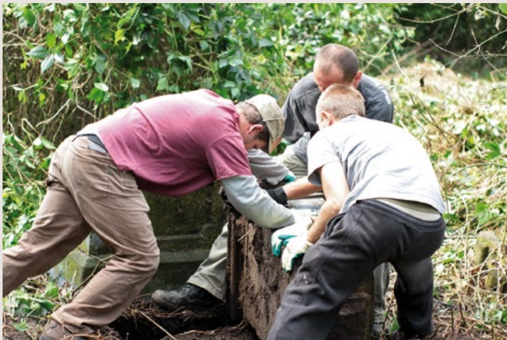
Husynne. W trakcie prac remontowych, wrzesień 2014. Fot. Agnieszka Kurasińska
