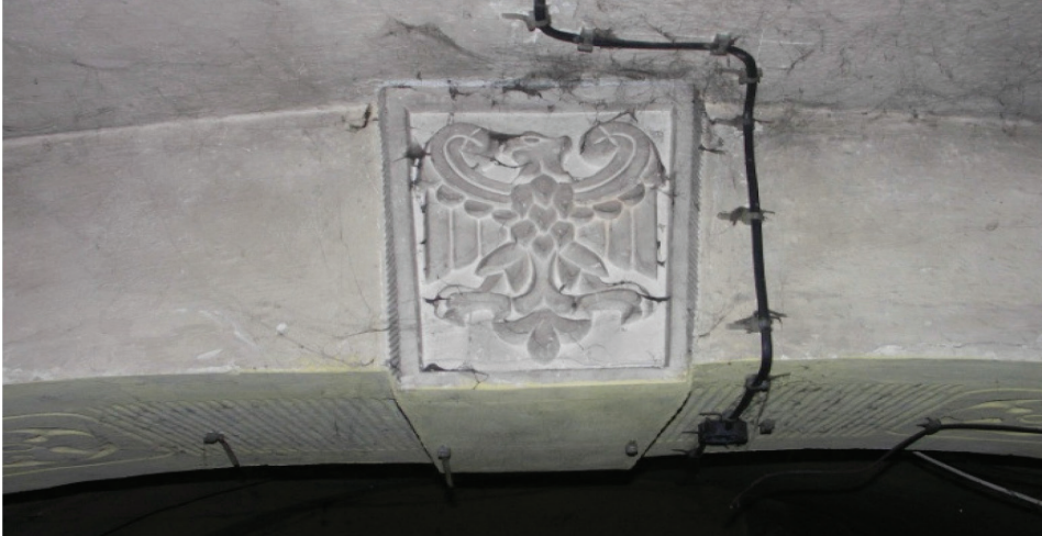
Ryc. 112. Budynek administracyjny, poziom piwnicy, fot. K. Janus 2012
