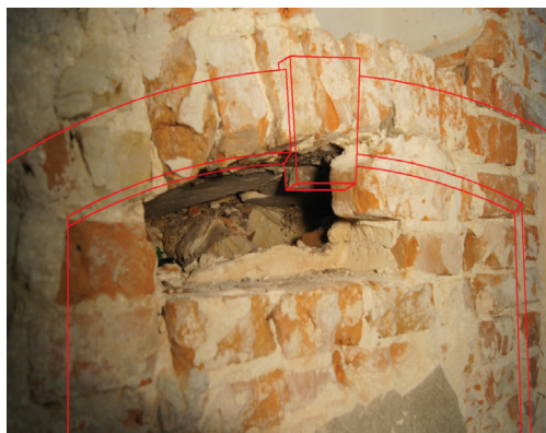
Ryc. 78. Wygląd opaski otworu okiennego sprzed dodania opłaszczowania ściany, skrzydło wschodnie na poziomie parteru, fot. i oprac.: K. Janus 2013
