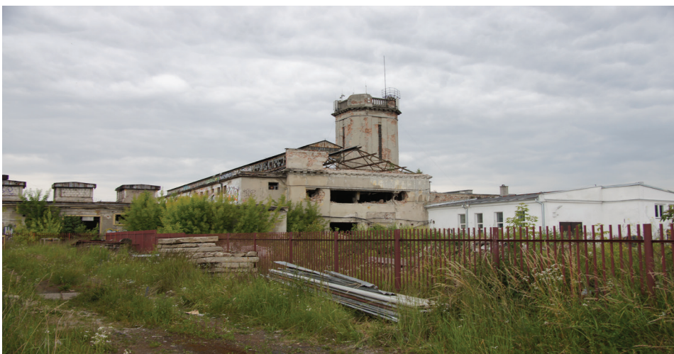
Ryc. 33. Rzeźnia miejska , A – zdjęcie z 1929 roku, archiwum PSOZ, B, C – stan z 2014 roku, fot. N. Przesmycka 2014
