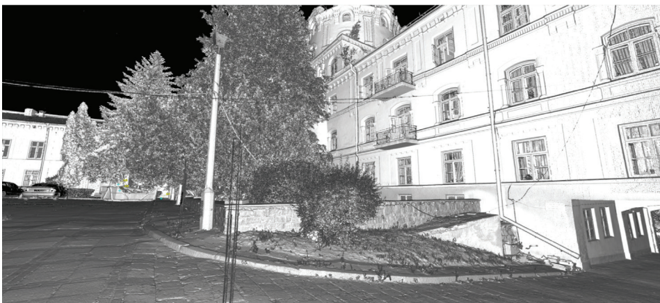
Ryc. 65. Elewacja frontowa dawnego pałacu, skan 3d, wyk. i oprac. K. Janus 2014
