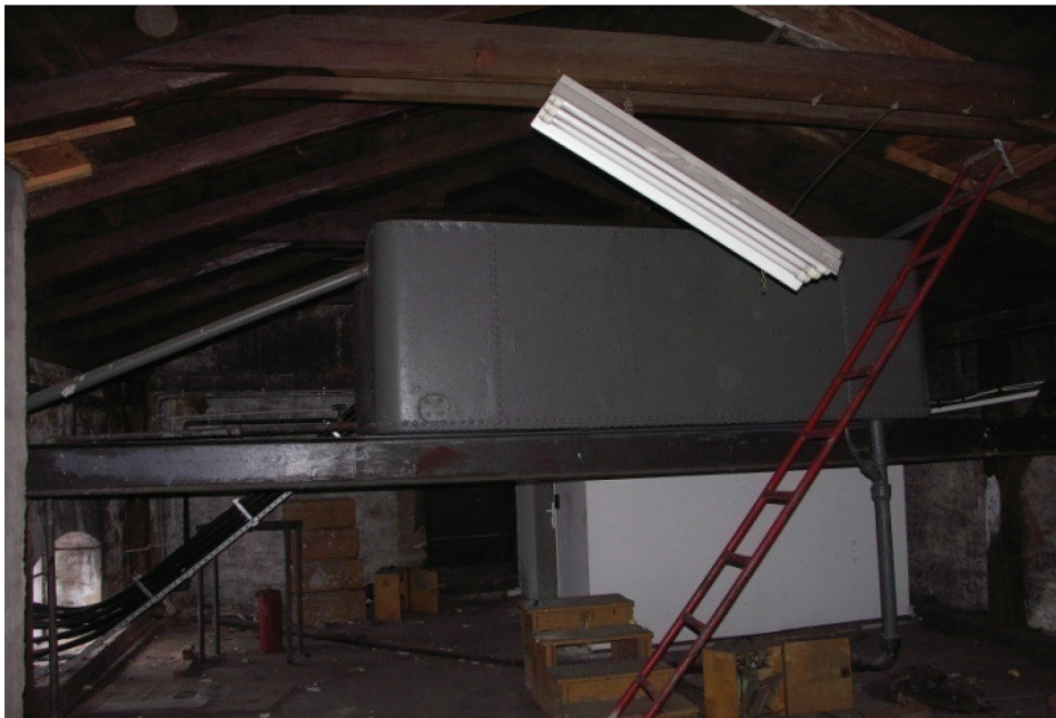
Ryc. 104. Zbiornik wyrównawczy, zachowana pozostałość po systemie rektyfikacyjnym, fot. K. Janus 2010
