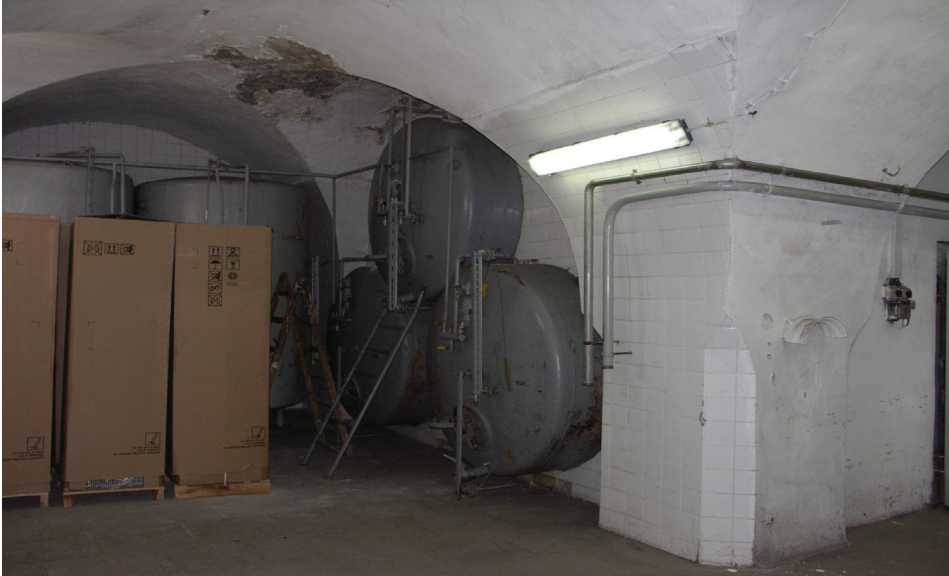
Ryc. 95. Budynek dawnego kościoła, poziom parteru, fot. K. Janus 2010
