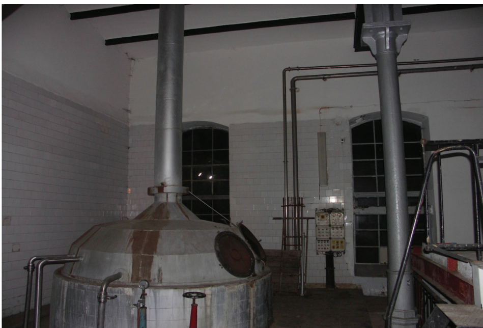
Ryc. 108. Budynek warzelni, poziom parteru, niefunkcjonujące kotły, fot. K. Janus 2010
