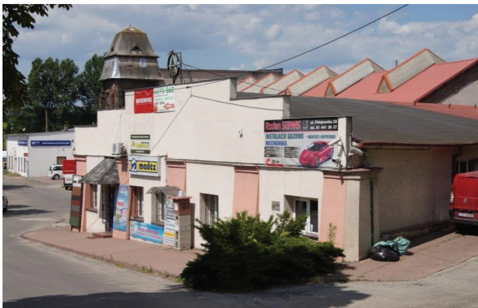
Ryc. 15. Fabryka eternitu, fot. N. Przesmycka 2014
