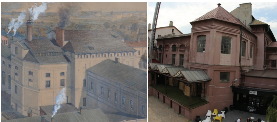
Ryc. 94. Porównanie widoku elewacja południowej dawnego kościoła przebudowana przez Vettera, przedstawionej na akwareli Eckert&Pflug, 1913 r. z widokiem obecnym, fot. K. Janus 2014
