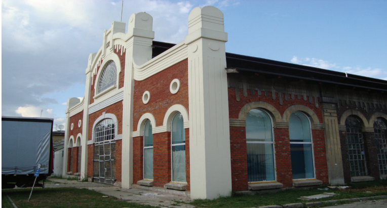
Ryc. 4. Jedna z pozostałych hal fabryki Wolskiego, stan w trakcie prac adaptacyjnych, rok 2008. Widoczne zmiany podziału stolarki okiennej, fot. N. Przesmycka
