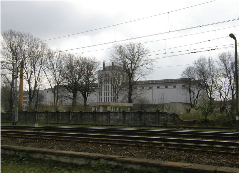
Ryc. 44. Zakłady Zbożowe widok od strony linii kolejowej, fot. N. Przesmycka 2008
