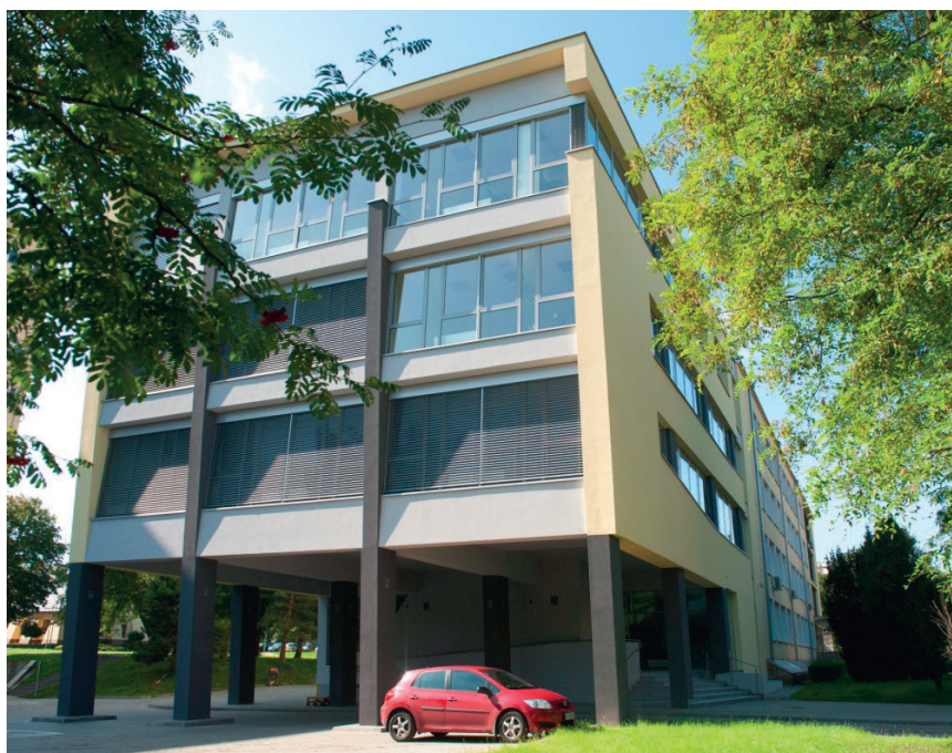
Nowa część budynku Wydziału Elektrotechniki i Informatyki PL
