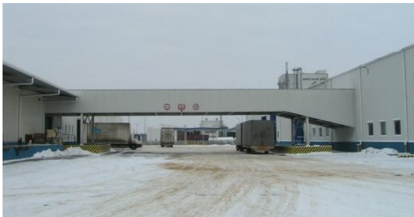
Rys. 5.29. Widok na estakadę [17]
