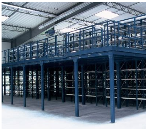
Rys. 9.2. Hala magazynowa z antresolą magazynową [50]
