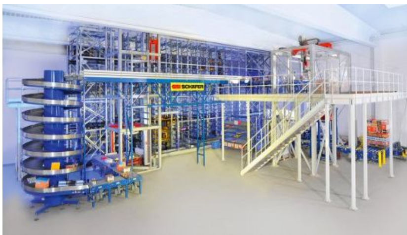
Rys. 8.5. Zautomatyzowany cykl kompletacji z wykorzystaniem robota paletyzującego na przykładzie systemu SCP [34]
