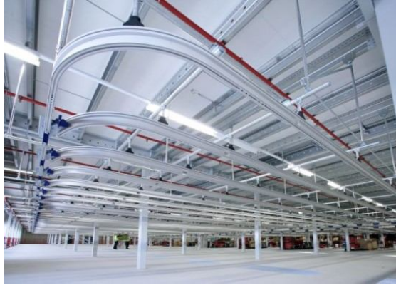
Rys. 5.16. Układ torów systemu transportu podwieszanego [43]
