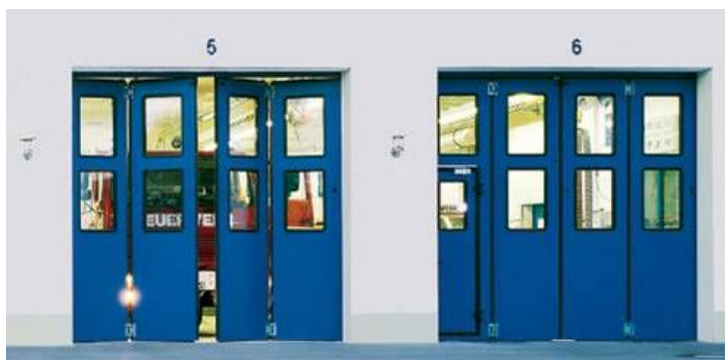
Rys. 12.5. Przykład zastosowania bramy składanej [41]
