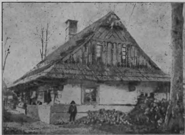
Rys. 14. Śląsk Austryacki, dom w Trzycieźu z r. 1801 ze szczytem i daszkiem przyźbowym. (Glogler. Budown. drzewne).
