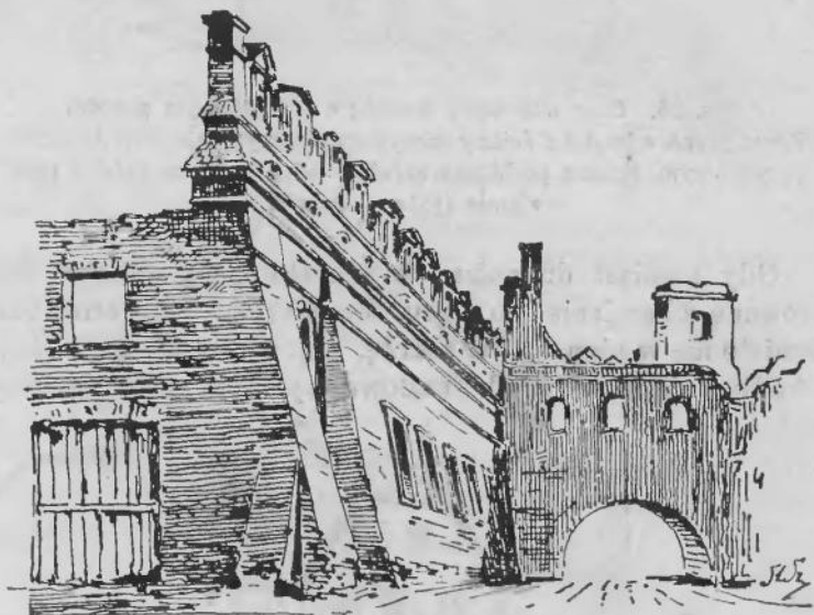
Rys. 27. Lublin. Rozwaliny szpitala Ś-go Ducha w Lublinie, założonego w r. 1342, zburzonego w r. 1851. Ściana zbudowana skarpowato.
