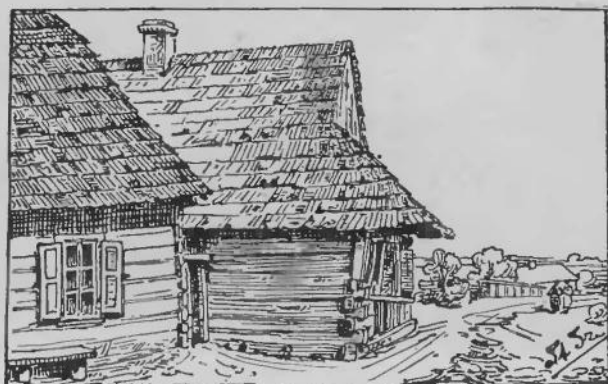
Rys. 55. Chata w Inowłodziu nad Pilicą, pow. Rawski. Trójkąt szczytowy silnie od lica ściany cofnięty.
