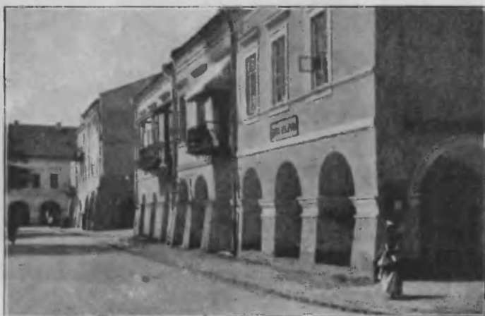
Rys. 31. Zamość. Domy podcieniowe ze słupami zbudowanymi skarpowato.
