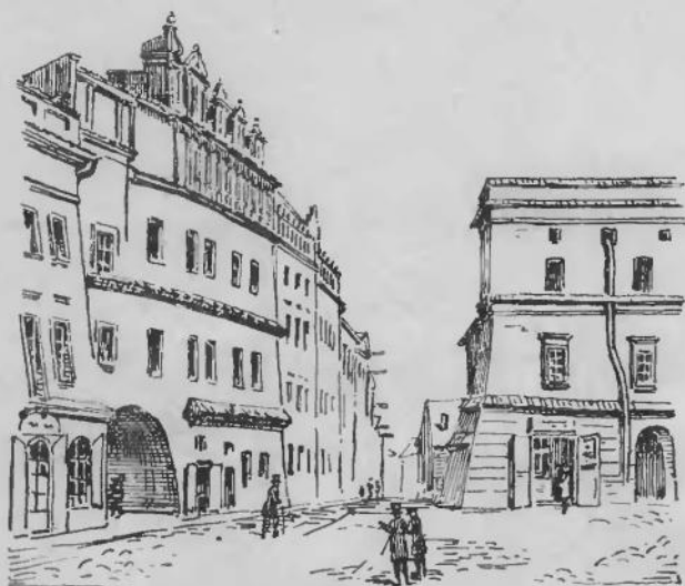
Rys. 28. Lublin. Rynek i ul. Grodzka według albumu Lerue, domy ze ścianami zbudowanymi skarpowato.
