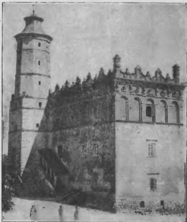
Rys. 50. Sandomierz. Ratusz z attyką i wieżą w kształcie ośmiobocznego słupa ustawionego na słupie czworobocznym. Na wieży liczne odsadzki pokryte okapami.
