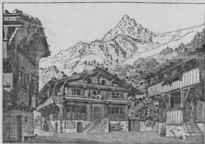
Rys. 57. Domy szwajcarskie budowane na zrąb („Blockbau“) ze ścianami nawieszonemi na belkach stropowych. (Glödbach, Holzarchitektur der Schweiz).
