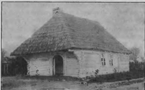
Rys. 12. Złoczew w Kaliskiem. Stara karczma z dachem przyźbowym na rysiach, ochraniającym podjazd. (Ze zbiorów Tow. Krajoznawczego).
