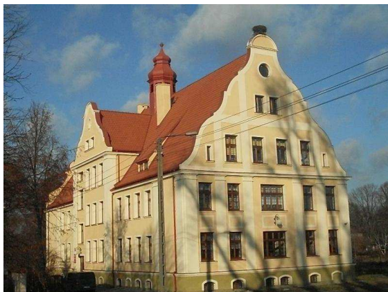
Budynek Szkoły Podstawowej i Liceum Ogólnokształcącego w Ornecie
