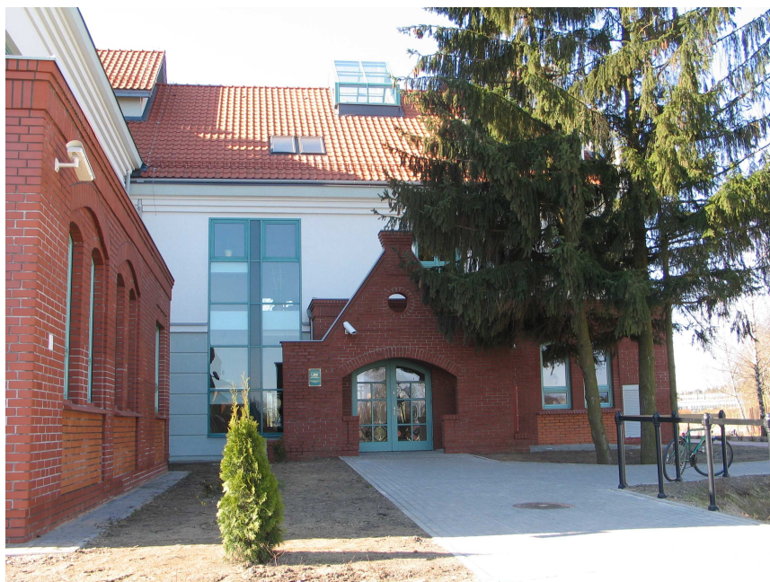
Budynek Katedry Biotechnologii w Ochronie Środowiska (widok od frontu)
