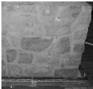
Fot. 10.10 Widok zamontowanych sond igłowych w murze
