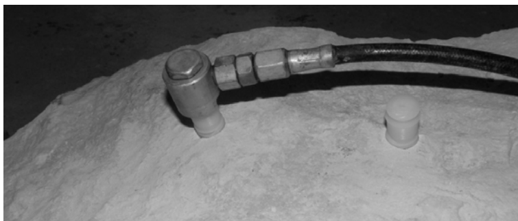
Fot. 10.3 Proces tłoczenia preparatu
