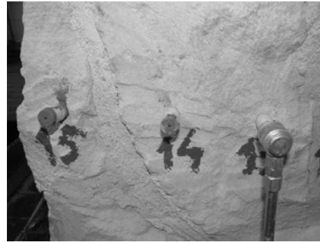
Fot. 10.13 Tłoczenie zaprawy trasowej
