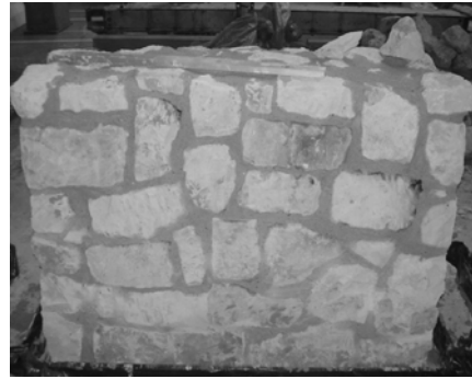
Fot. 10.7 Ukończony mur nr 2
