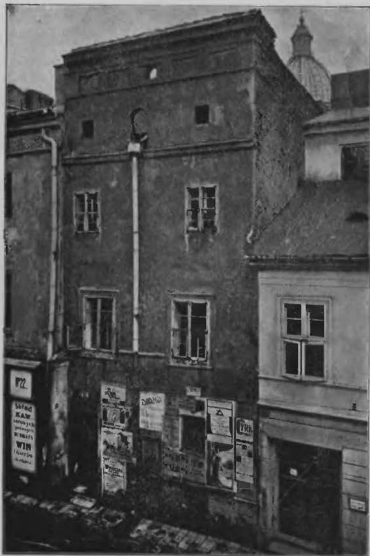
Wiz. 767. Kamienica „dwupolowa” z resztkami ściany czołowej. Kraków, ul. Szewska. Dom już zburzony.
