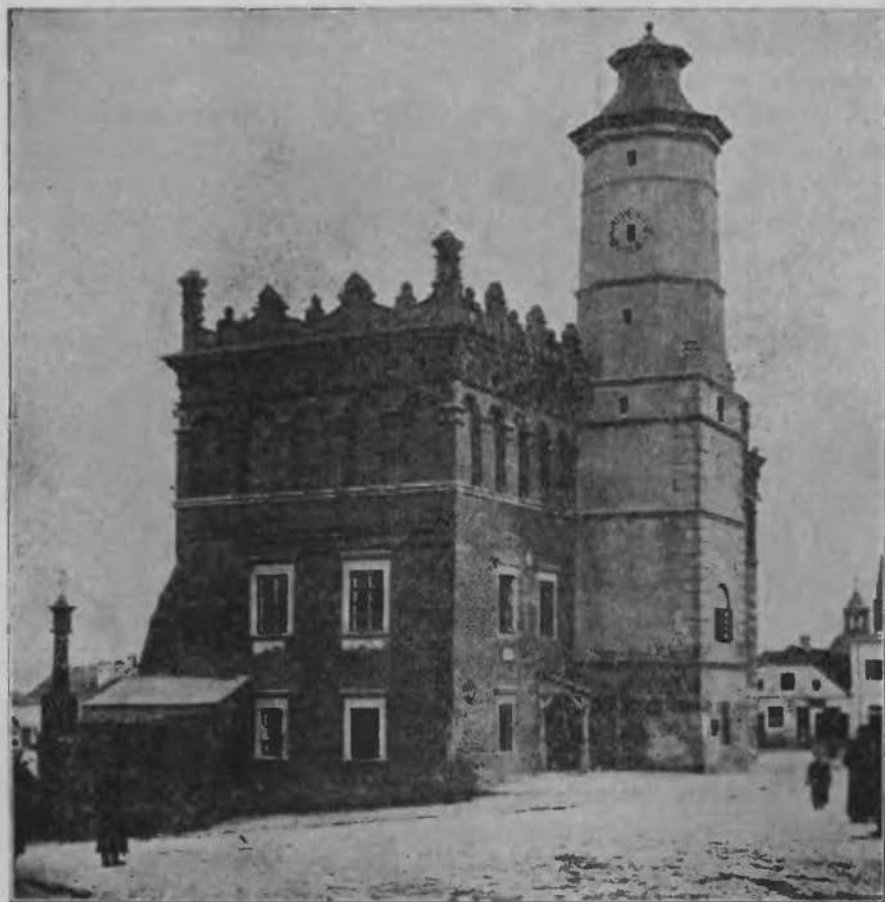
Rys. 777. Widok ratusza w Sandomirzu, ze ścianą czołową w cegle wykonaną.
