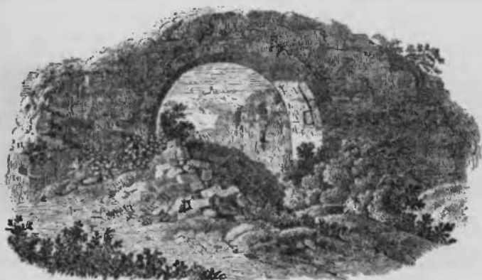
Rys. 595. Łęk sklepienny z granitu, wykonany jako część wnętrza ze świątyni pogańskiej na Ostrowiu Lednicy.
