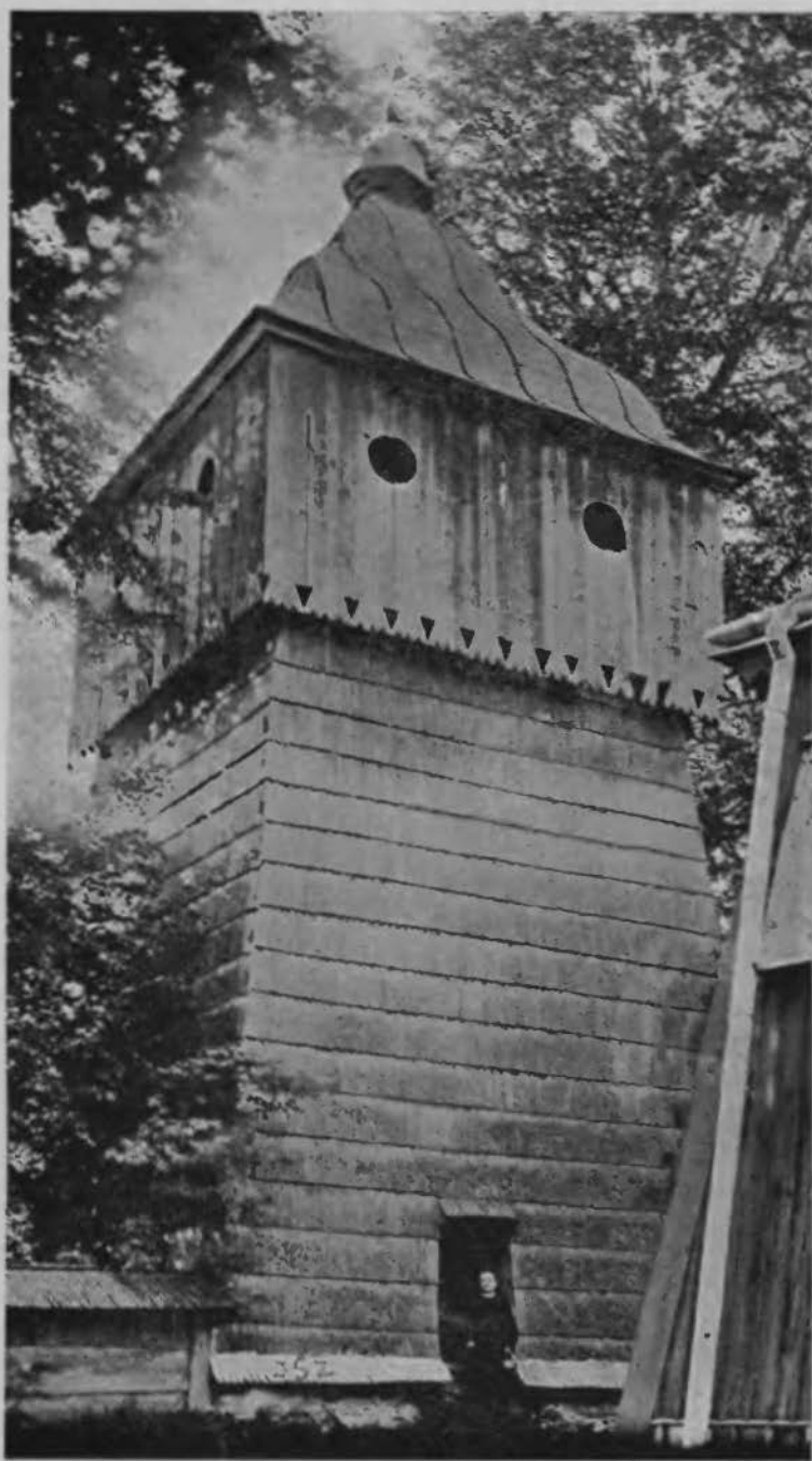
Wiz. 574. Dzwonnica przy kościele drewnianym w Brzeznicy koło Dębicy. Zadaszenie o linii falistej.
