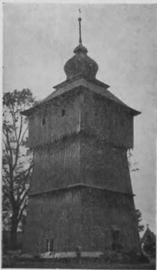
Wiz. 736. Dzwonnica z banią u góry, przy kościele w Jordanowie (zburzona).
