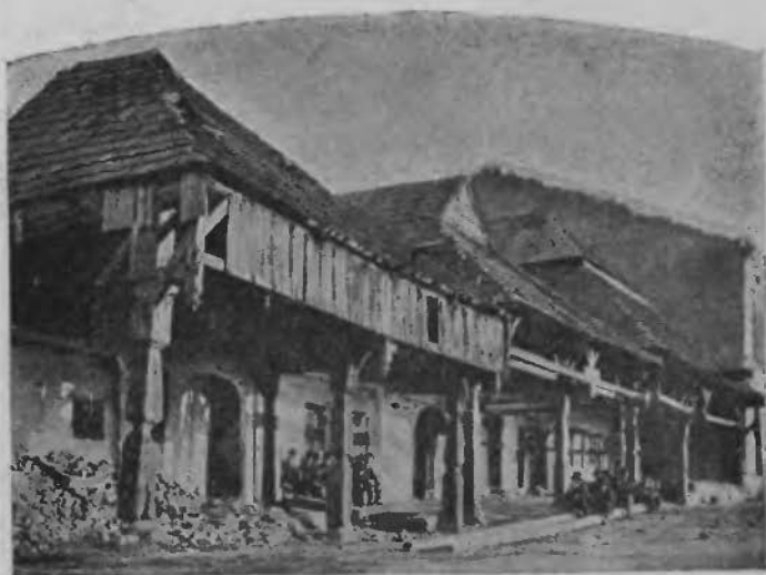
Wid. 567. Widok domów podcieniowych z miasta Ciężkowice (kolo Tarnowa). Przed słupami słupki wiszące „wiszary”. Przy ścianie słupy, stanowiące t. zw. „przyłap”. (Zdjęcie J. S. Z.).
