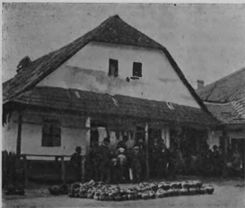
Wiz. 571. Dom podcieniowy w Tlustem na Podolu. Szczyt ma wierzch okapowy i „przystrzeszek”. (Zdjęcie J. S. Z.).
