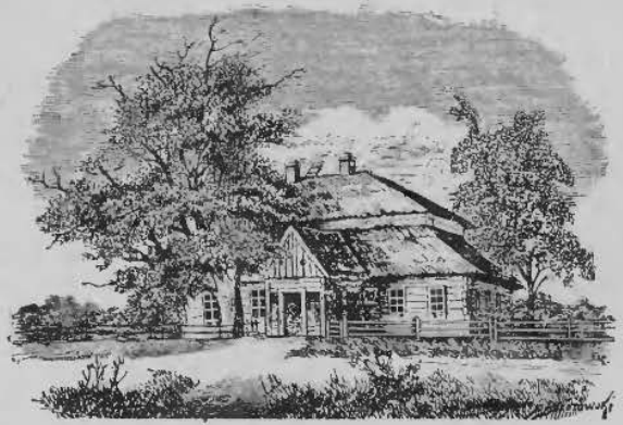
Rys: 210. Dom rodziony Tadeusza Kościuszki (Mereczowszczyzna) — przed odnowieniem. Dach dwoisty, ze ścianką kolankową w połowie wysokości. Ganek cztero-słupowy.
