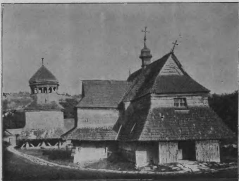
Wiz: 159. Widok cerkwi drewnianej na Czortkowie Starym, tuż koło Czortkowa nad Seretem. Budowla niema kopuł żadnych. Dzwonnica jest wzorem wieży baniastej. Na przedzie cerkwi dwa okienka „w kątomir“.
