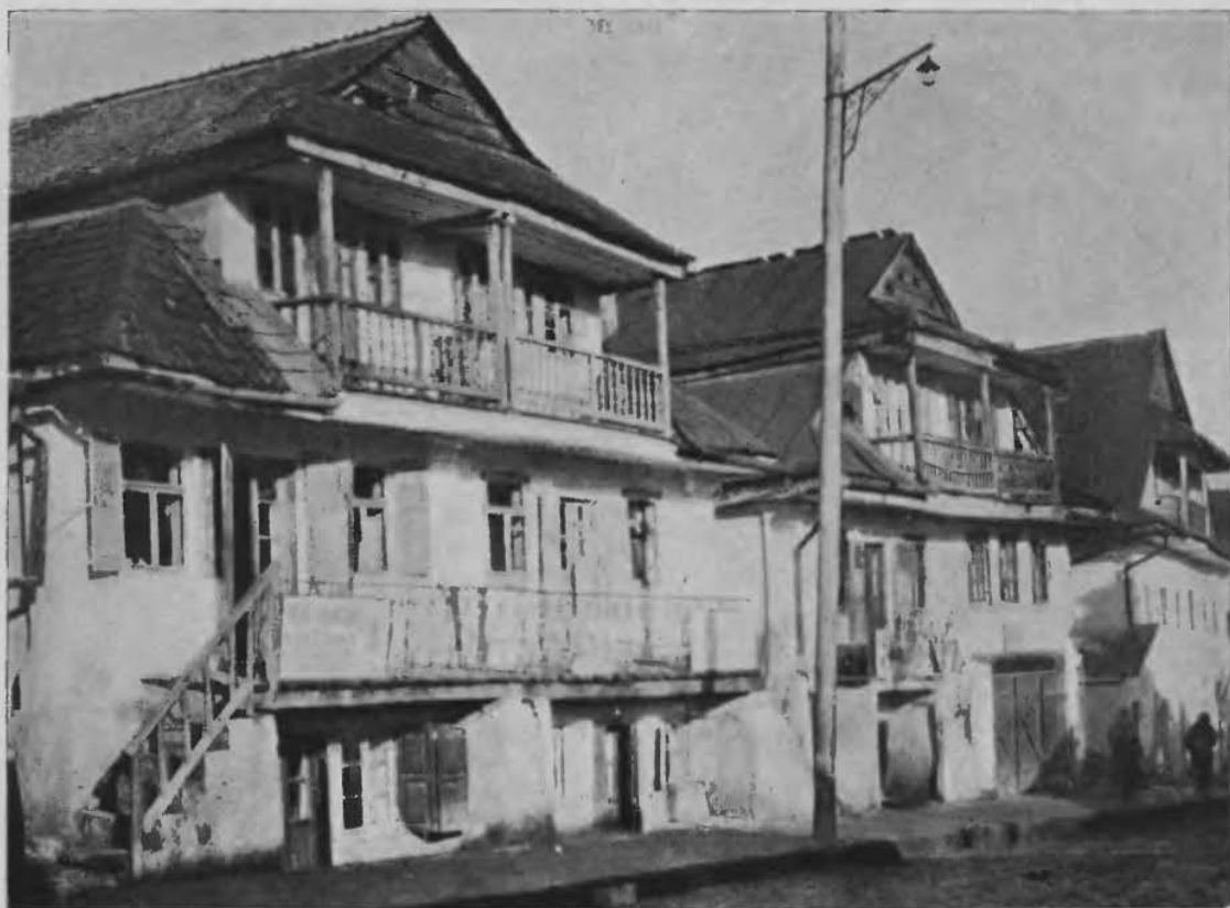
Wiz: 129. Domy w Krzemieńcu z gankami, u góry trzysłupowymi, od strony ulicy. Ciesiołka w szczegółach bardzo zniszczona i przy naprawach zastępowana słupami bez ozdób żadnych. Założenie atoli całości i rozkład brył ogromnie malowniczy. Okaz jeden z najpiękniejszych w Polsce. (Zdjęcie własne: J. S. Z.)
