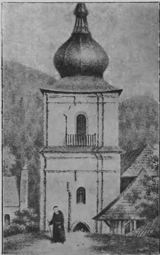
Rys: 200. Kopuła na wieży bramnej przy cerkwi bazylijskiej w Dobromilu. Bania na ośmioboku o narożach osiowych.
