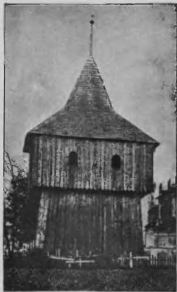
Rys: 130. Dzwonnica z daszkiem ostrosłupowym, ośmiościennym, o krawędziach z osi głównych i osi przekątniowych. (Przy kościele w Beszowej.)
