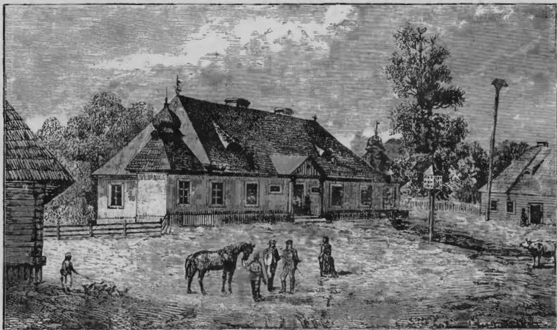
Rys. 160. Stary dwór polski z dwiema bokówkami po narożach, przechodzącymi górą w wieże baniaste, które dołem czworoboczne, górą ośmioboczne. Dwór modrzewiowy w Sadowiu — ziemia Kielecka. Na sosnóbie rok 1755.
