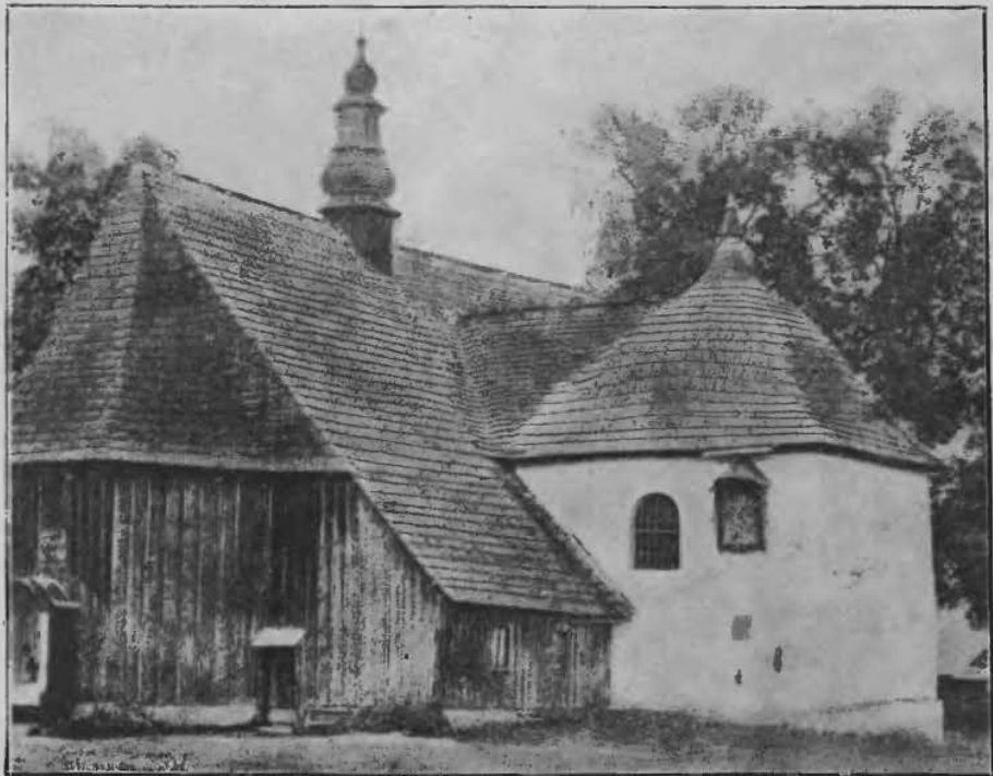
Wiz: 181. Kościół stary w Jordanowie pod Babiogórą, z kaplicą przymurowaną, a nakrytą banlą z ośmiokątą wychodzącą, a mającą grzbietownice po osiach.
