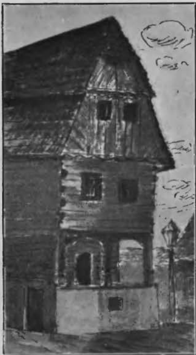
Rys: 227. Dom stary z Morawji o podcieniu dwuprzęsłowym u dołu na zasadzie dwudziału, który odznaczony jest aż do szczytu. (Arch. Fiala z Ostrawy Moraw.).
