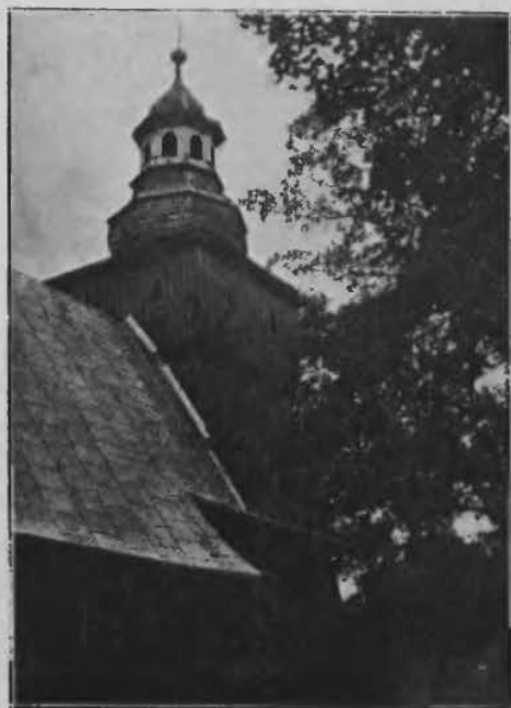
Wiz: 183. Skrzydlna koło Limanowej. Kopuła z czwartaka przychodzi do ośmiomiru z osi głównych i przekątniowych. (Zdjęcie Zbign. Wzorka).
