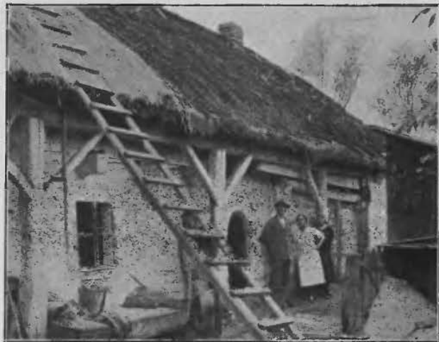
Wiz: 214. Dom „z przyźbą” to jest ze słupami mieczowanymi a oddalonymi od ściany o grubość słupa. (Grzegórkki, koło Krakowa). Zdjęcie własne.
