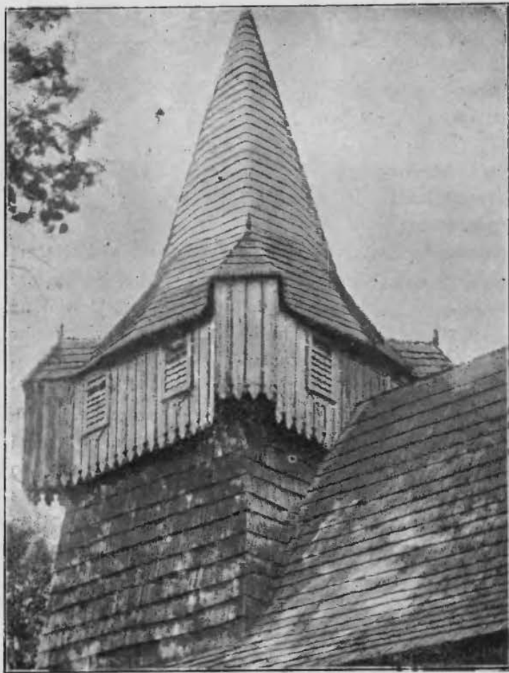
Wiz: 303. Wieża w Woli Radzichowskiej koło Skawiny o igrlicy ostrosłupowej z osi głównych i przekątniowych wychodzącej, tudzież z wieżyczkami do „miru“ ukośnego.
