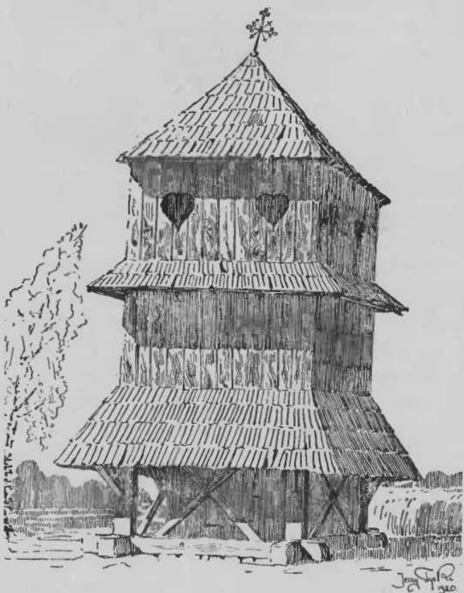
Rys: 120. Dzwonnica z dachem ostrosłupowym cztero-ściennym w Leśniowicach.
