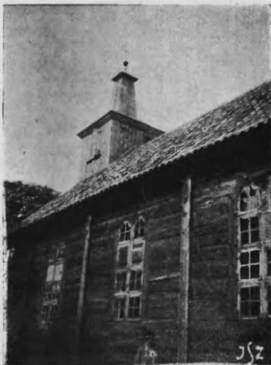
Wiz : 43. Kościół drewniany w Jastarni koło Heli. Okno czysto polskie podwójnie dwudzielne w kierunku poziomym, zaś poezwornie dwudzielne w kierunku pionowym. Pola pojedyncze wedle „Kątomira“.
