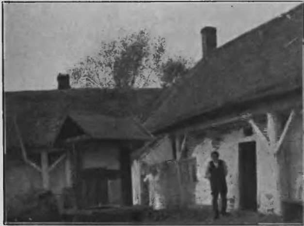
Wiz: 213. Dom „z przyźbą” to jest o słupach oddalonych od ściany, z mieczami – na Grzegórkach, koło Krakowa. (Zdjęcie własne).
