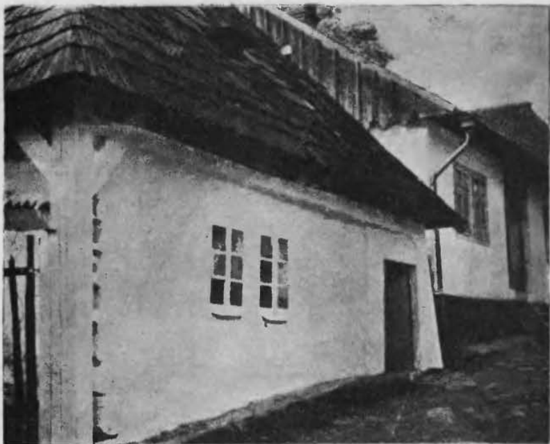
Wiz: 42. Dom rodzinny Ks. Bronisława Markiewicza w Próchniku, koło Przeworska. Przykład doskonały słupów mieczowanych, przyłapu staropolskiego. Ściany wieńcowe wzmocnione słupami „przyłapu“.
