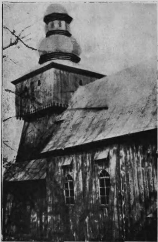
Wiz: 172. Kościół drewniany w Rogowie koło Dukli, na Podkarpaciu. Wieża z dzwonnica nadwieszoną koronkowo i z banią o krawędziach po osiach głównych i przekątniowych.
