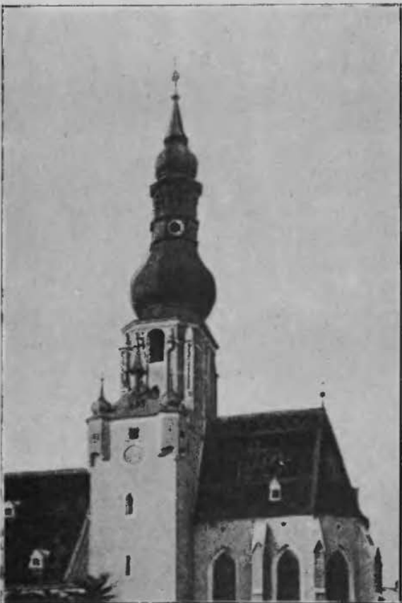
Wiz: 174. Zwieńczenie wieży baniastej na kościele parafjalnym w Badenie koło Wiednia. Kopała szesnastoboczna dołem, górą ośmioboczna — z krawędziami po osiach.
