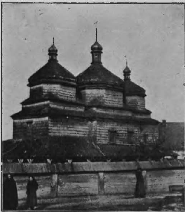
Wiz: 156. Widok cerkwi starój w Płustém na Podolu, ze sobótkami dockoła. Trzy wieże baniaste są pozostałością z piątnicy.
