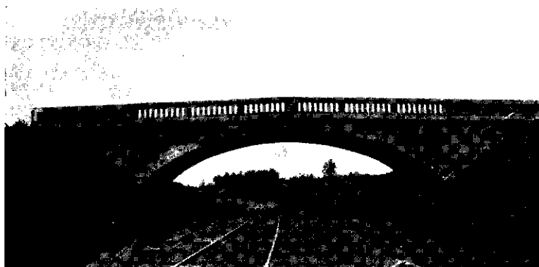
Fot. 18. Wiadukt betonowy nad torem kolejowym na szosie brzezińskiej pod Łodzią.
