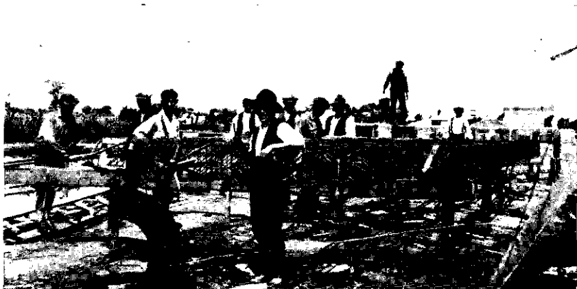
Fot. 9. Wykonywanie uzbrojenia pali żelazobetonowych dla mostu na rz. Wisłoku w Tryńczy.
