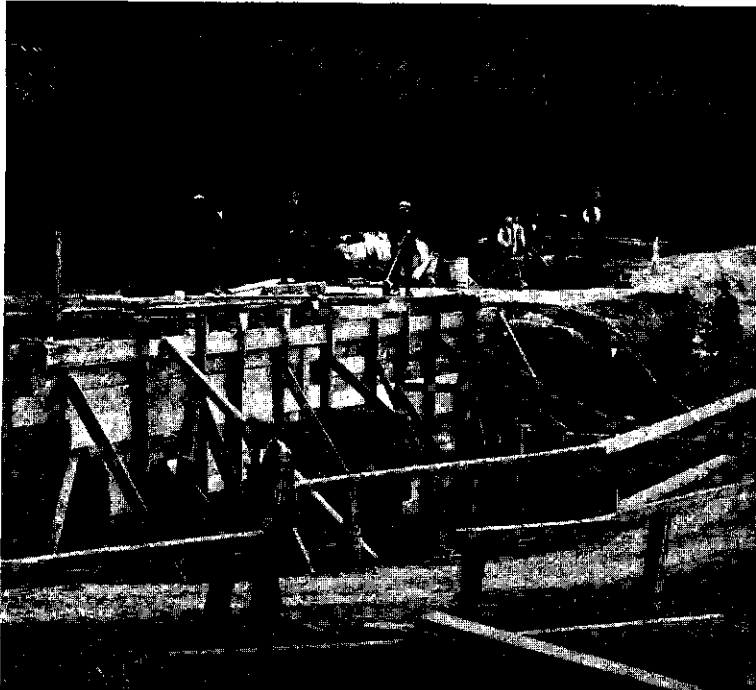
Fot. 46. Kompletne rusztowanie dla przepustu betonowego na rz. Liszni obok Drohobycza.
