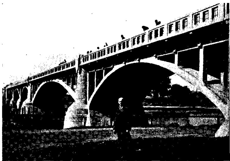
Fot. 1. Ogólny widok mostu na rz. Sole w Oświęcimiu.
