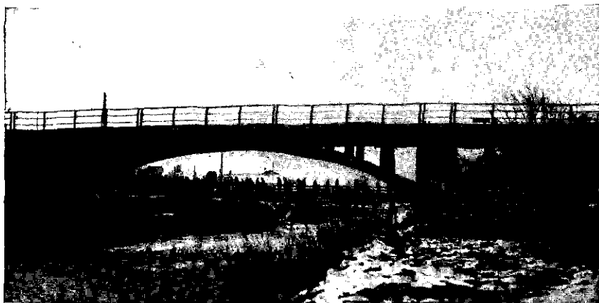
Fot. 32. Łukowy most żelazobetonowy na rz. Ropie w Gorlicach.
