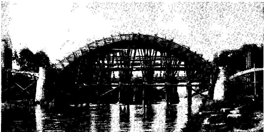
Fot. 40. Betonowanie środkowego przęsła mostu na rz. Wisłoku w Rzeszowie.
