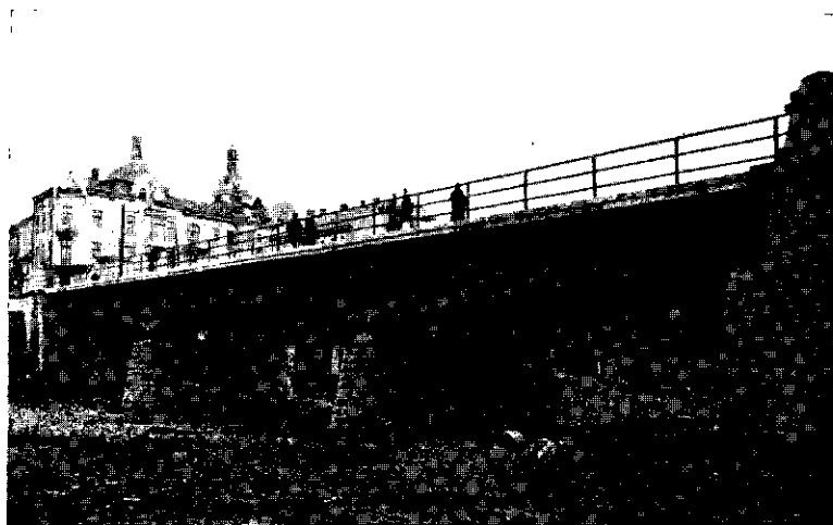
Fot. 20. Most o belce ciągłej na rz. Kamienicy pod Nowym Sączem.
