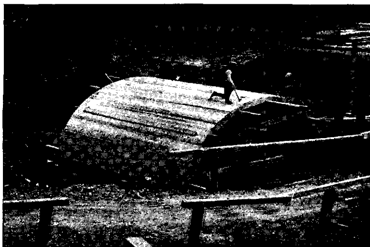
Fot. 45. Szalowanie krążyn przepustu betonowego na rz. Liszni obok Drohobyca.
