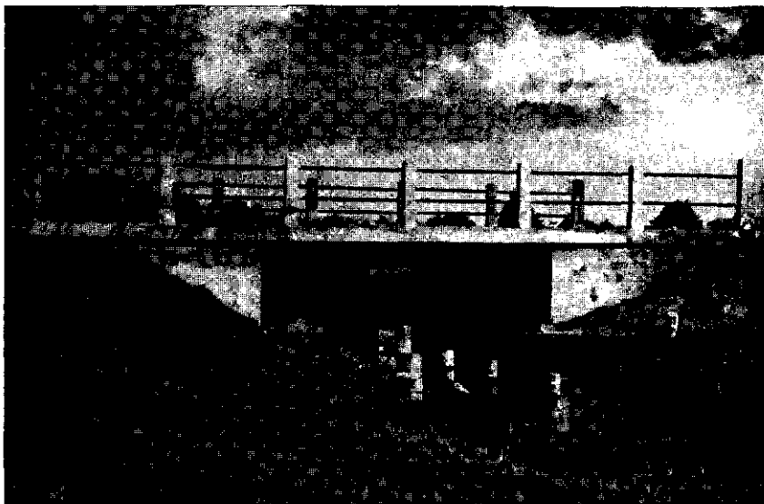
Fot. 30. Żelazobetonowy most belkowy na drodze Czernsk-Chojnice.
