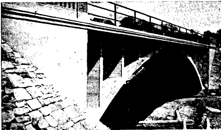
Fot. 5. Most łukowy na rz. Przemysce pod Delatynem, w silnym ukosie.
