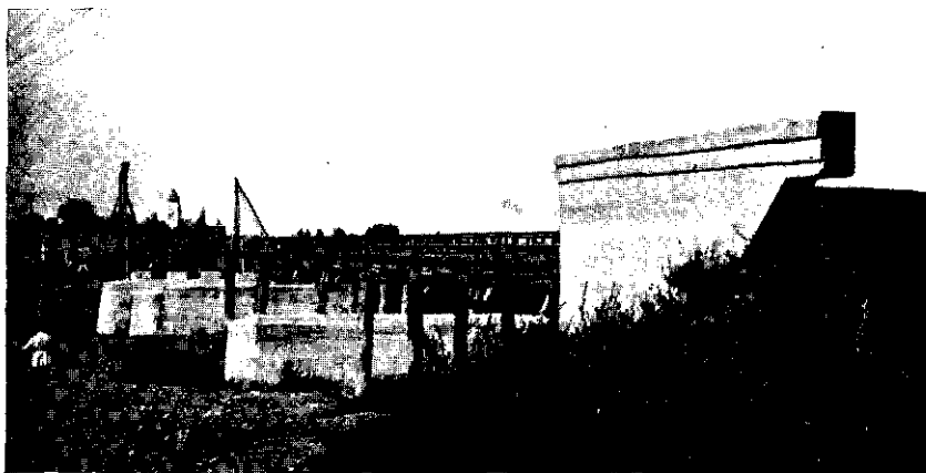
Fot. 14. Przyczółek i filary mostu na rz. Bystrzycy w Mykietyńcach. Charakterystyczne skrzydła wiszące.
