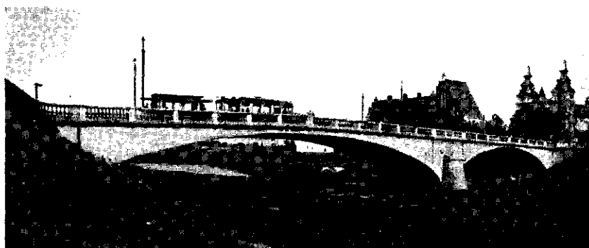
Fot. 2. Widok mostu Bolesława Chrobrego w Poznaniu.
