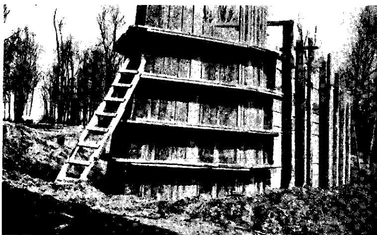
Fot. 43. Szalowanie filaru mostu na rz. Sanie w Brandwicy.
