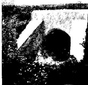
Fot. 26. Przepust betonowy pod Kosowem Poleskim.
