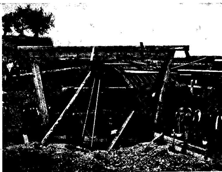
Fot 44. Ustawianie krajyn dla przepustu betonowego na rz. Tarnawce pod Laszkami Murowanemi.
