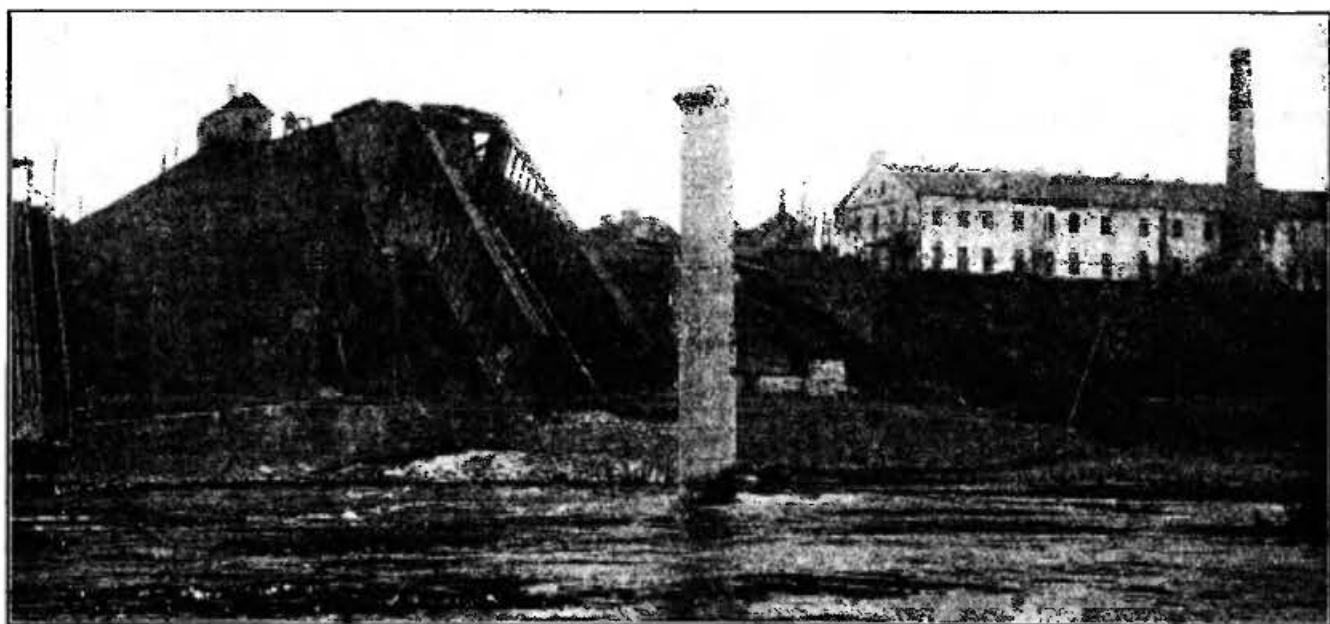
Most przez rzekę Niemen pod Grodnem Widok zniszczonego mostu starego.
