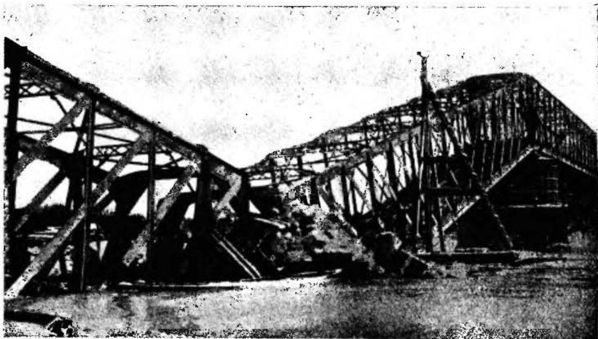
Zniszczony most przez rzekę Słucz na linii Sarny—Ostki.
