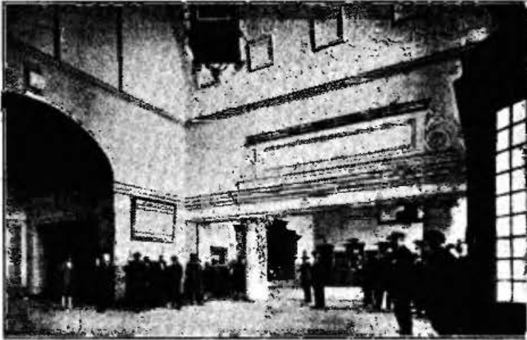
Hala dworca na stacji Gdynia.
