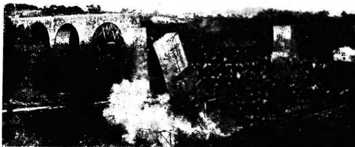
Przygotowanie do odbudowy stałej wiaduktu Lubiążnia.
