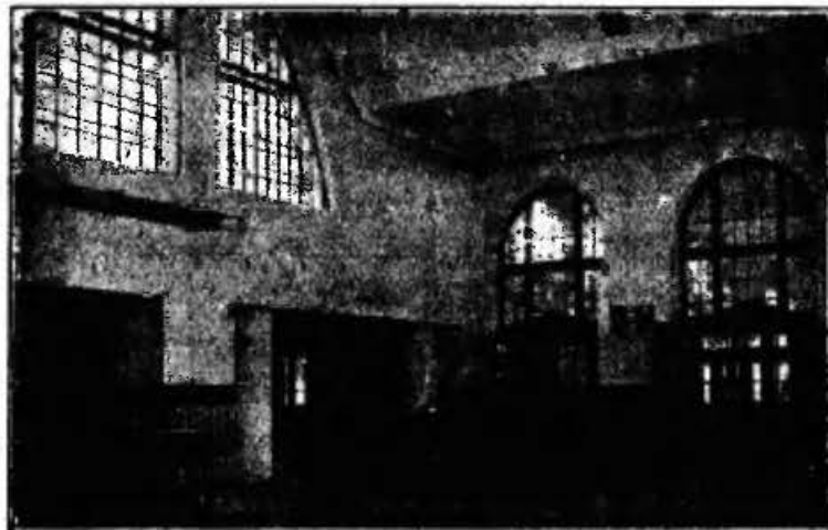
Wnętrze hali dworca na stacji Stołpce.
