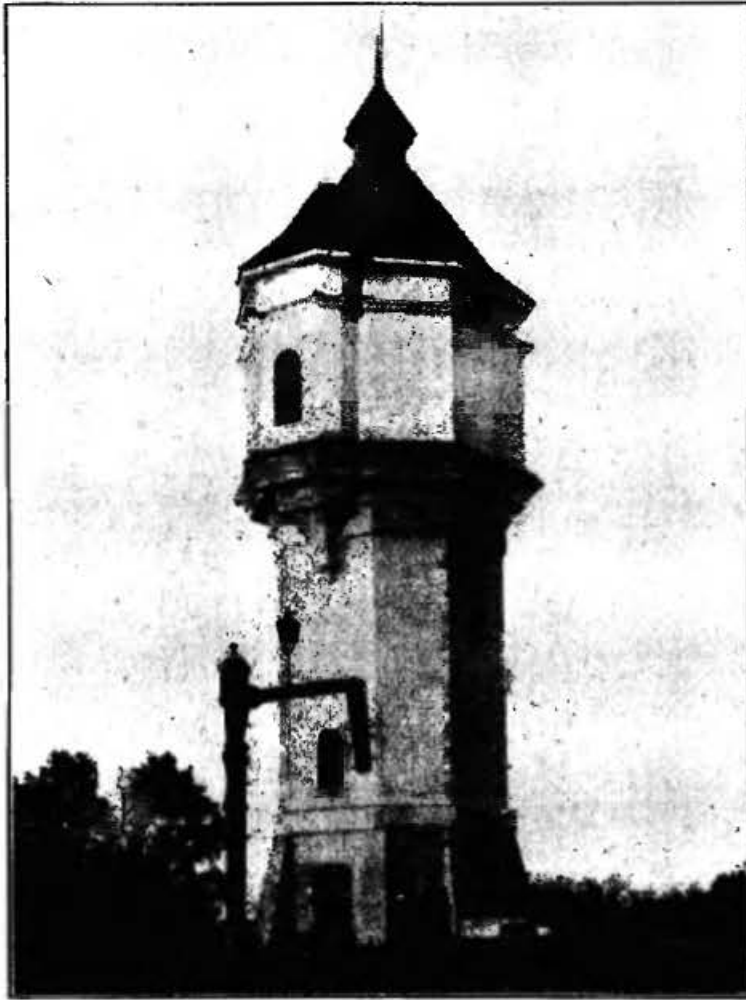
Odbudowana wieża ciśnień.
