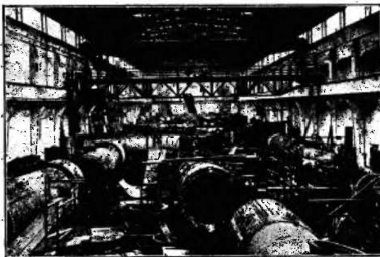
Poznań. Warsztaty Główne. Kotłarnia.
