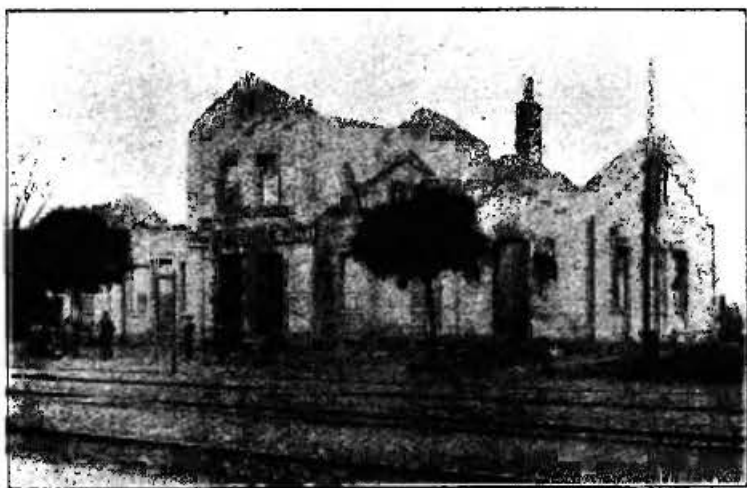
Zburzony dworzec na stacji Sądowa Wisznia.
