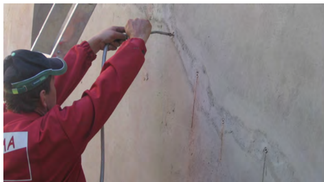
Rys. 1.1. Iniekcyjne wypełnianie pęknięcia muru
