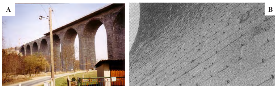
Rys. 1.3. Most w dolinie rzeki Elstery: a) widok ogólny, b) pakery iniekcyjne zamontowane na powierzchni przęsła (fot. b za [34])
