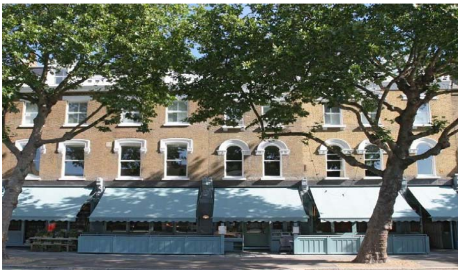
Rysunek 4.14. Budynek High Road House (HRH)
