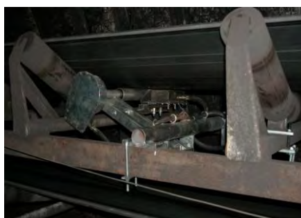
Rys. 5.8 - Elementy układu pomiarowego na trasie przenośnika: a) czujnik, b) zestaw pomiarowy
