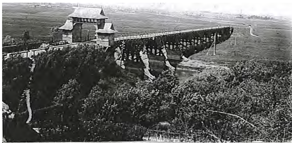
Fot. 21b. Most przez rzekę Bug w Zosinie rok budowy - 1922
