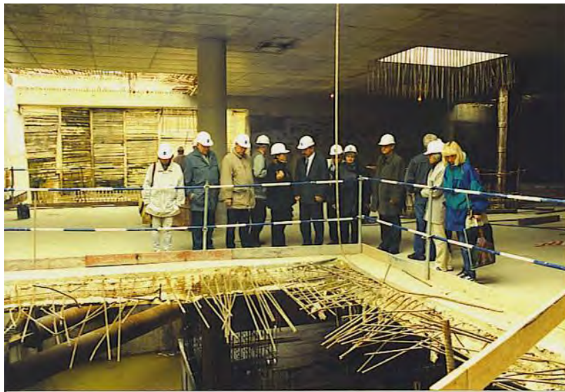
Wycieczka techniczna do Warszawy – budowa stacji metra na Placu Bankowym 2000 r.
