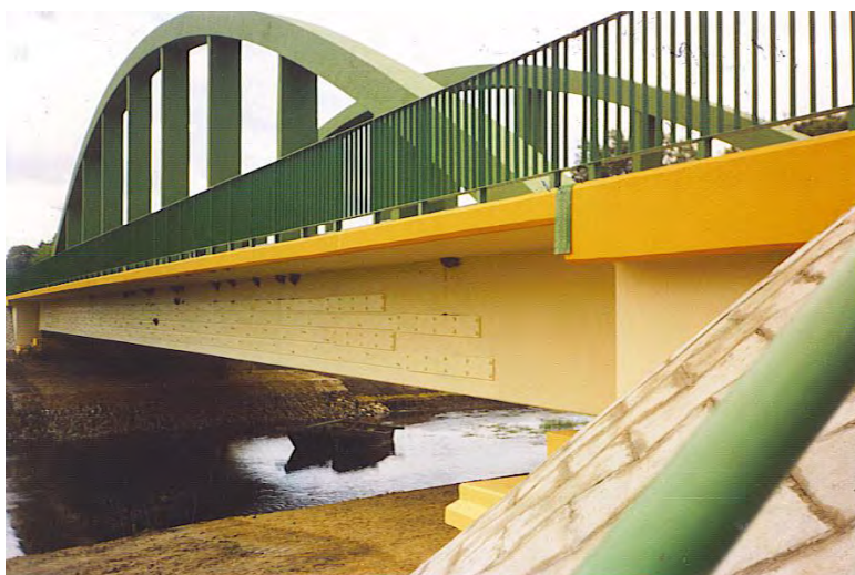
Fot 18. Most przez rzekę Huczwę w Teptiukowie k/Hrubieszowa po wykonanym wzmocnieniu konstrukcji
