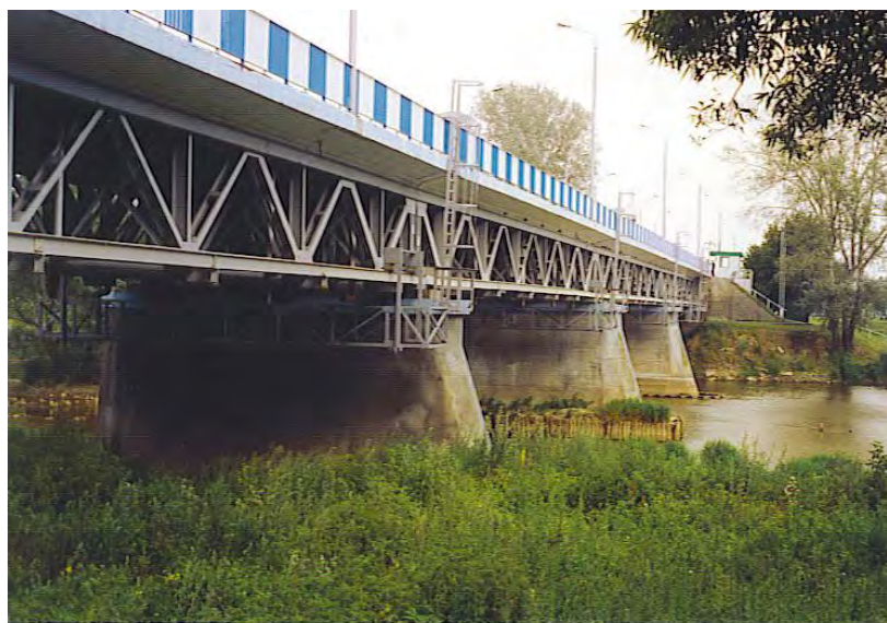
Fot.22. Most przez rzekę Bug w Terespolu rok budowy 1955/
