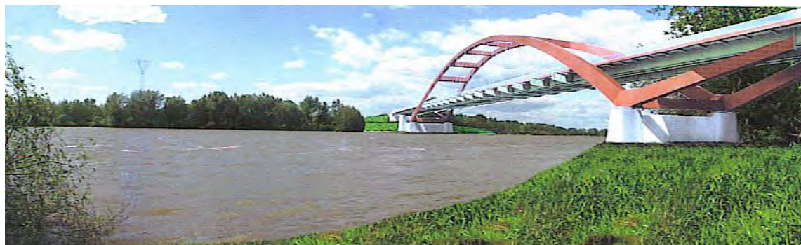
Fot. 24. Most w budowie przez rzekę Wisłę na obwodowej miasta Puławy długość mostu 1038 m.
