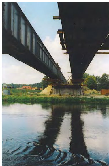
Fot. 15. Poszerzenie istniejącej konstrukcji ustroju nośnego mostu przez rzekę Wieprz w Kośminie
