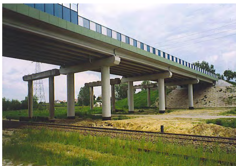
Fot. 17. Wiadukt w miejscowości Sitaniec w ciągu drogi Lublin – Zamość nad linią kolejową LHS.
