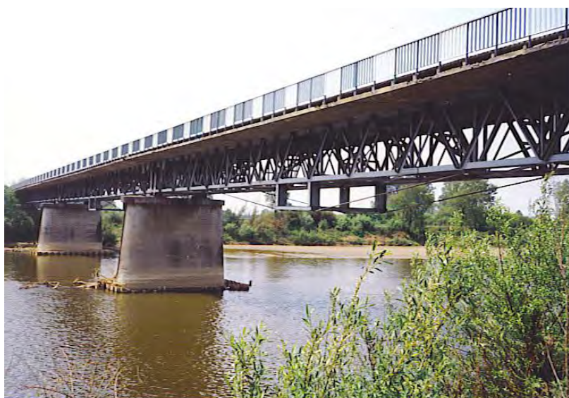
Fot. 11. Most przez rzekę San w Ulanowie – wzmocniony kablami zewnętrznymi.
