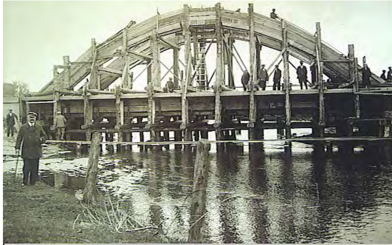
Fot.1. Budowa mostu przez rzekę Białą Ładę w Bilgoraju. Most przekazany do ruchu w roku 1928.
