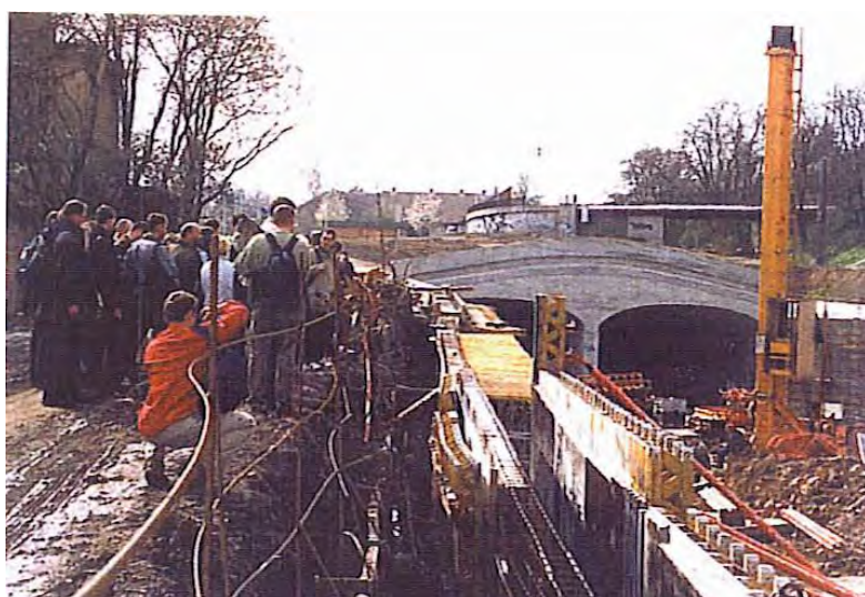
Młodzież Koła PL – zwiedzanie robót w ciągu obwodnicy Pragi Mrazowka – budowa tunelu
