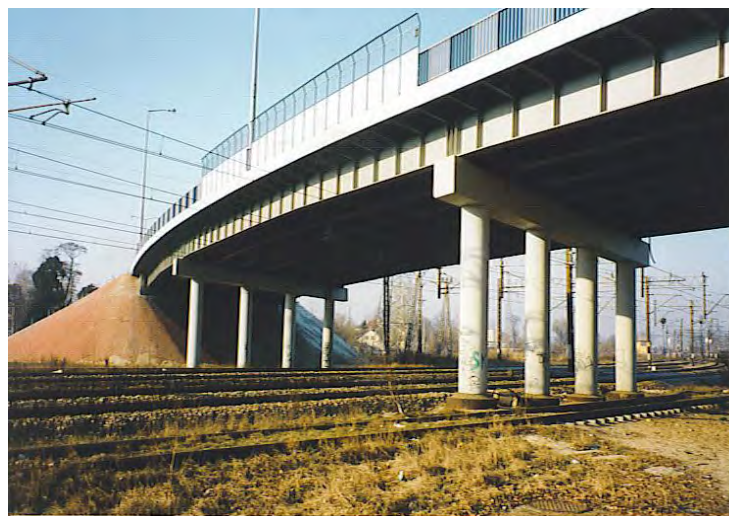
Fot. 14. Wiadukt w Dęblinie nad linią kolejową Warszawa – Lublin. Lata budowy 1995 – 1996. Wykonawca PBM Lubartów i Mostostal – Puławy.
