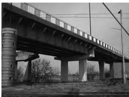
Rys. 7.100. Widok ogólny wiaduktu.
