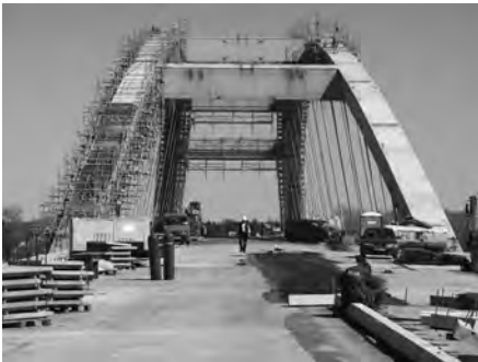
Rys. 7.60. Most w Puławach (pomost bez warstw izolacyjnych i jezdnych).
