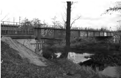
Rys. 7.27. Widok ogólny kładki.
