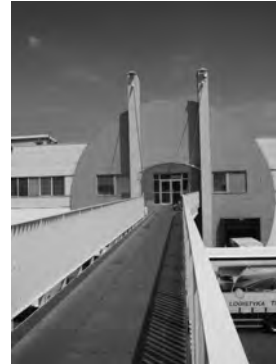
Rys. 7.44. Widok kładki z perspektywy pieszego.
