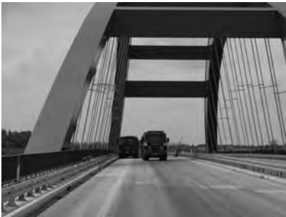
Rys. 7.62. Most w Puławach (most wykonany w całości).
