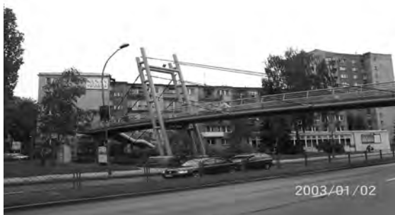
Rys. 7.1. Widok ogólny kładki.
