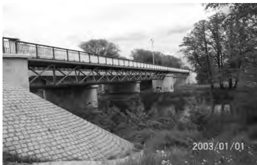
Rys. 7.15 Widok ogólny kładki w Osjakowie.
