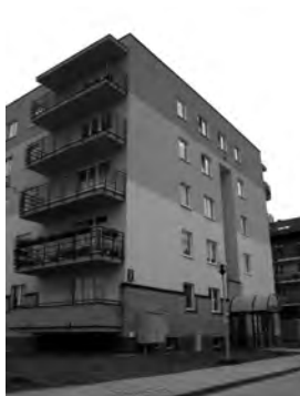
Rys. 7.127. Budynek, w którym znajduje się badany strop.
