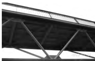
Rys. 7.16. Widok pomostu kładki od dołu.
