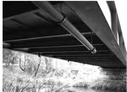
Rys. 7.28. Widok pomostu od dołu.
