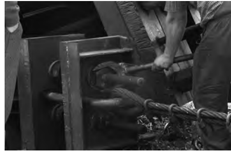
Rys. 7.147. Czynności modernizacyjne kładki.
