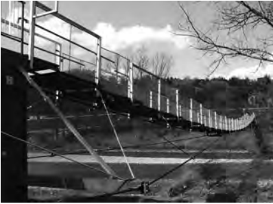
Rys. 7.146. Ogólny widok kładki.
