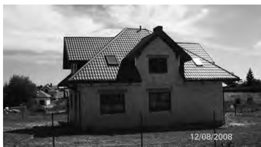
Rys. 7.139. Budynek, w którym przeprowadzono badania drgań stropu.
