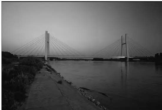
Rys. 7.86. Widok z boku Mostu Siekierkowskiego w Warszawie.
