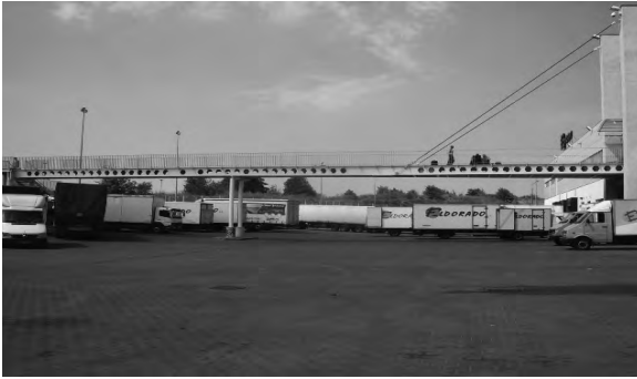
Rys. 7.43. Widok ogólny kładki.
