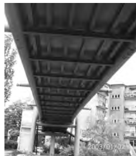
Rys. 7.2. Widok kładki od dołu.
