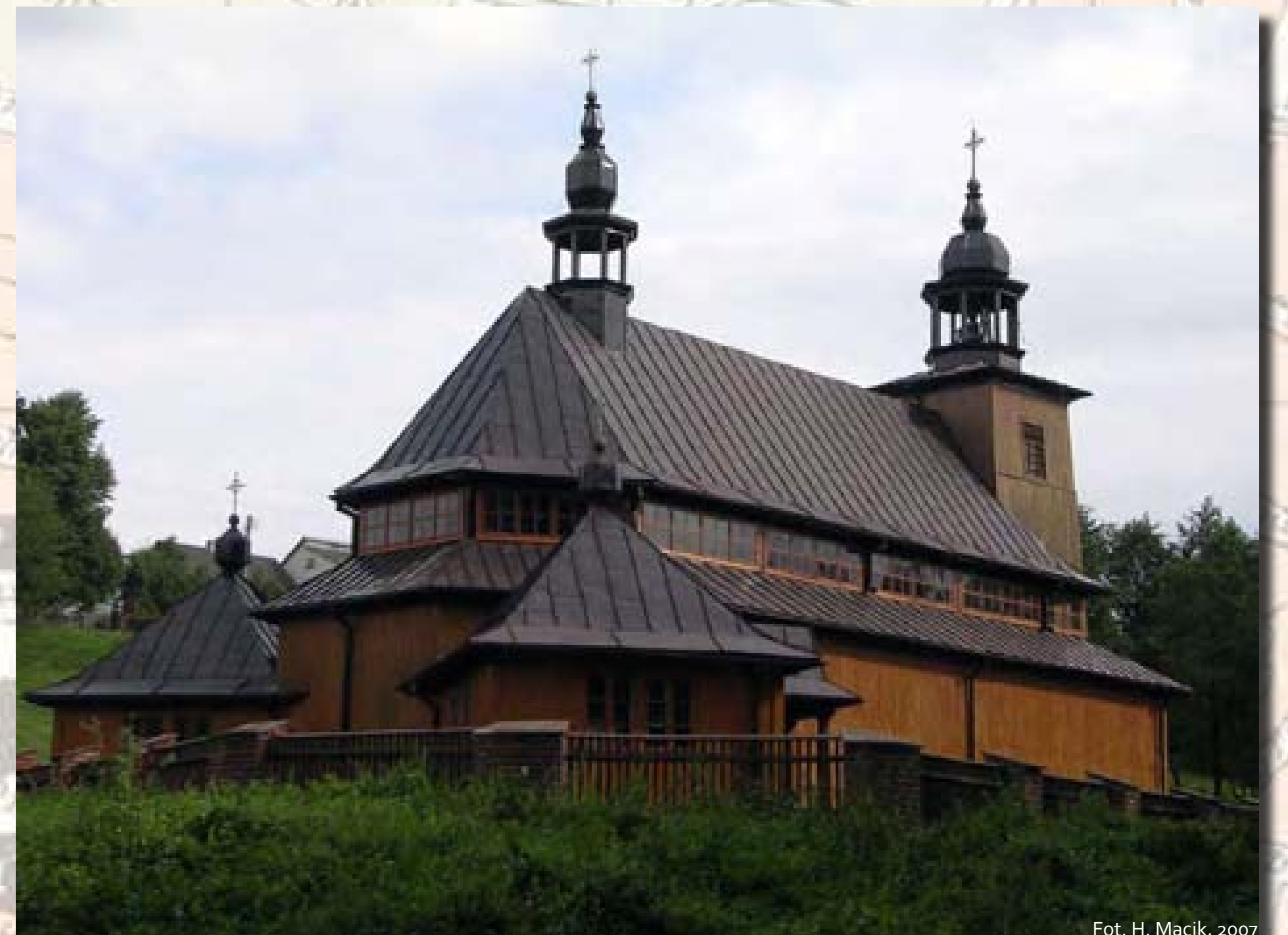
Kościół pw. Najświętszego Serca Jezusowego, 1933-1934, proj. Tadeusz Witkowski, od 1985 roku w Pilaszkowicach
