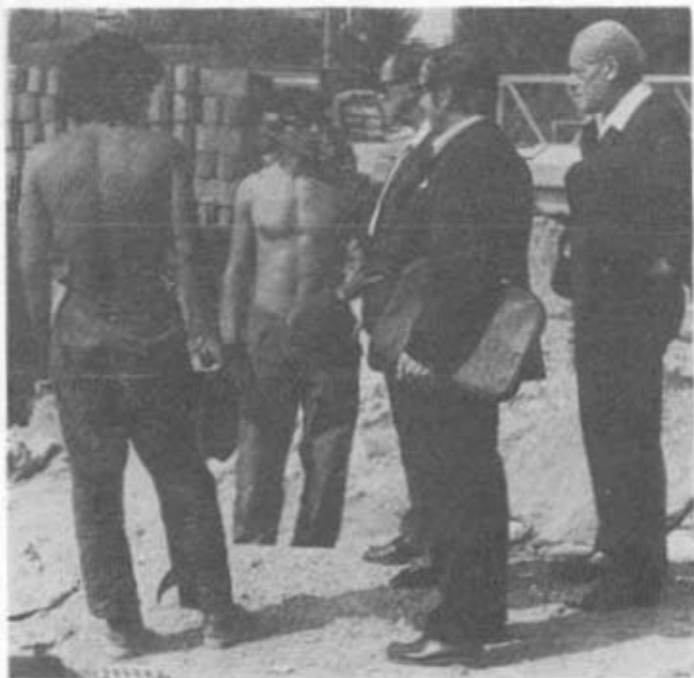
Kierownictwo uczelni zainteresowane pracą studentów często odwiedzało hufce na placach budowy
