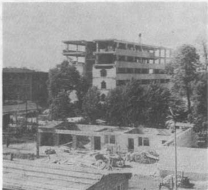
Plac budowy kompleksu budynków dla WSInż.
