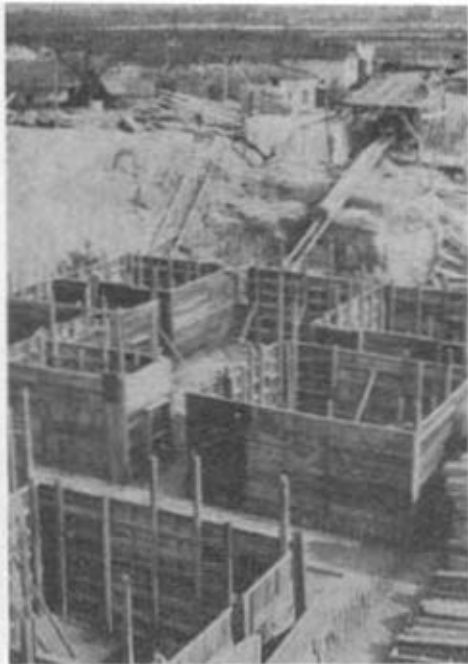
To początek budowy kolejnego, trzeciego domu studenta WSiłn.
