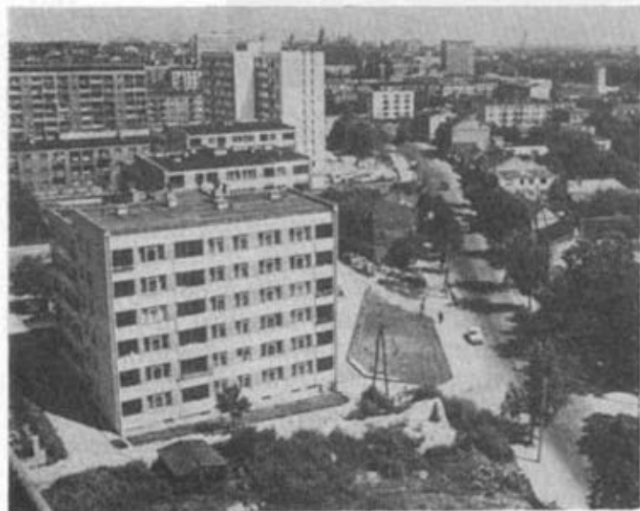
Po prawej stronie ul. Nadbystrzyckiej rozciąga się plac, gdzie w niedalekiej przyszłości staną duże budynki lubelskiej szkoły politechnicznej
