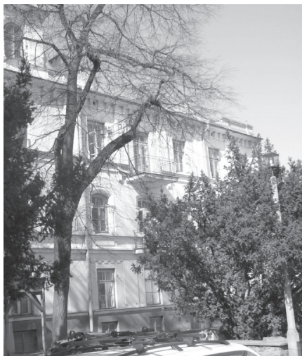
II. 3. Stan istniejący pałacu Sobieskich przy ul. Bernardyńskiej – fragment budynku głównego. Fot. autora, 2008.
