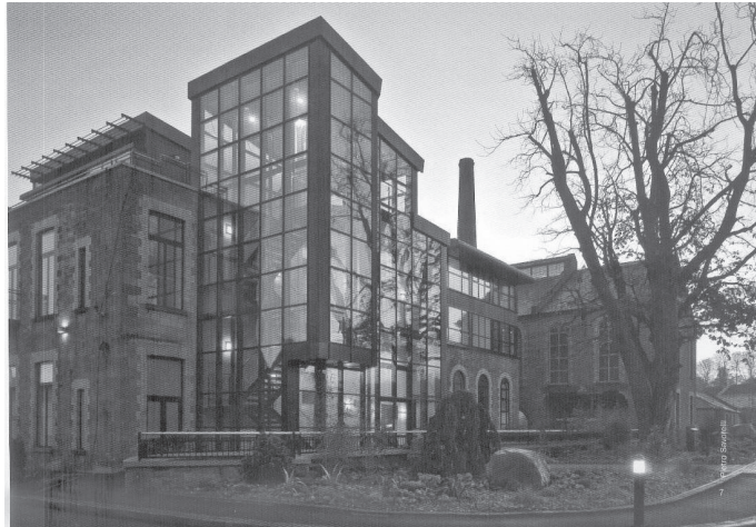
II. 2. Szklano-żeliwna zewnętrzna klatka schodowa.
