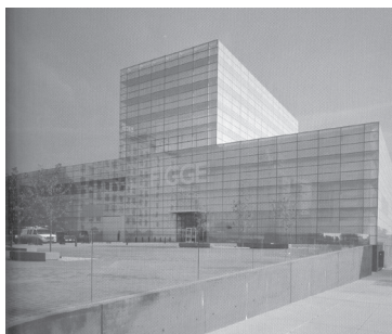
II. 8. Widok z zewnątrz.
