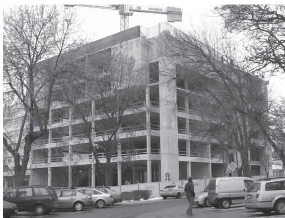
II. 12, 13, 14. Budowa WICA. Fot. autora, 2011-2012.
