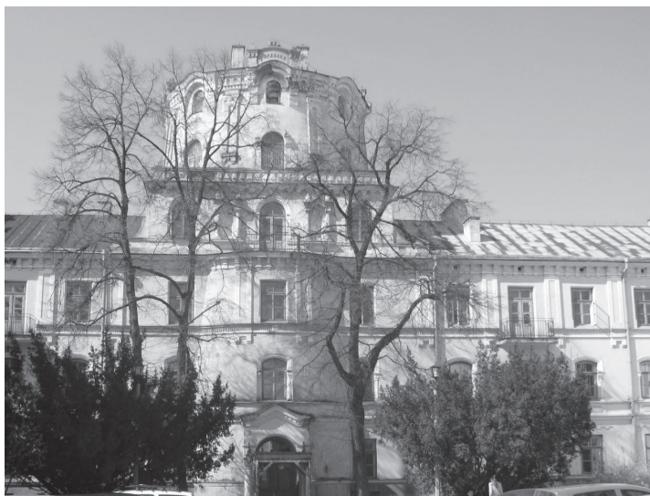
II. 1. Stan istniejący pałacu Sobieskich przy ul. Bernardyńskiej. Fot. autora, 2008.
