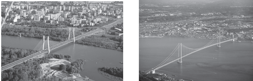
Ilustracja 2. Od lewej: a) Most Siekierkowski w Warszawie o konstrukcji podwieszonej, b) Most Akashi Kaikyo (Japonia) wiszący
