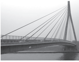
Rysunek 66. Most drogowy Lanaye w Belgii, 1980–1982, rozpiętość całkowita 232m, rozpiętość podwieszona 177m
