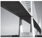
Rysunek 74. Most w Dame Point w USA, 1989, rozpiętość całkowita 3218m, rozpiętość podwieszona 396m
