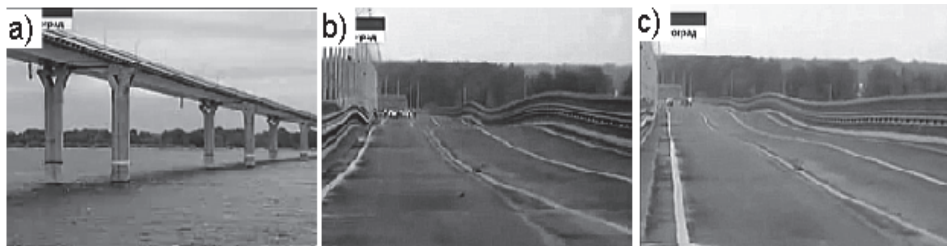
Ilustracja 4. Wzbudzenie aerodynamiczne mostu w Wołgogradzie w roku 2010, a) widok konstrukcji pomostu, b) c) drgający pomost
