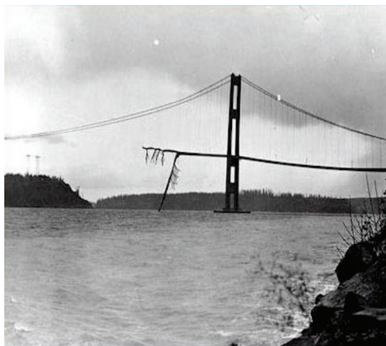
Ilustracja 1. Katastrofa Tacoma Narrows Bridge
