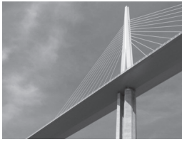
Rysunek 69. Wiadukt Milau we Francji, rozpiętość całkowita 2460m, rozpiętość podwieszona 342m
