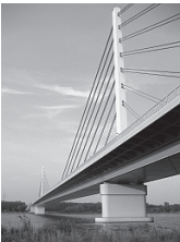
Rysunek 70. Most Solidarności w Płocku, 2007, rozpiętość całkowita 1200m, rozpiętość podwieszona 375m
