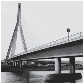
Rysunek 65. Most drogowy w Wandre w Belgii, 1989, rozpiętość całkowita 527m, rozpiętość podwieszona 411m
