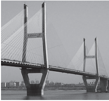
Rysunek 67. Drugi most Wuhan na rzece Jangcy w Chinach, 1995, rozpiętość całkowita 4678m, rozpiętość podwieszona 400m
