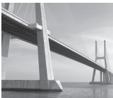
Rysunek 75. Most Vasco da Gama w Portugalii, 1998, rozpiętość całkowita 17185m, rozpiętość podwieszona 420m
