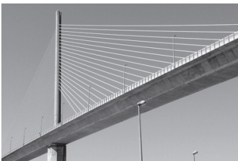
Rysunek 68. Most Brotonne we Francji, 1977, rozpiętość całkowita 1278m, rozpiętość podwieszona 320m
