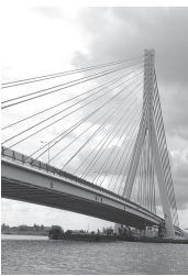
Rysunek 71. Most III Tysiąclecia im. Jana Pawła II w Gdańsku 2001, rozpiętość całkowita 380m, rozpiętość podwieszona 230m
