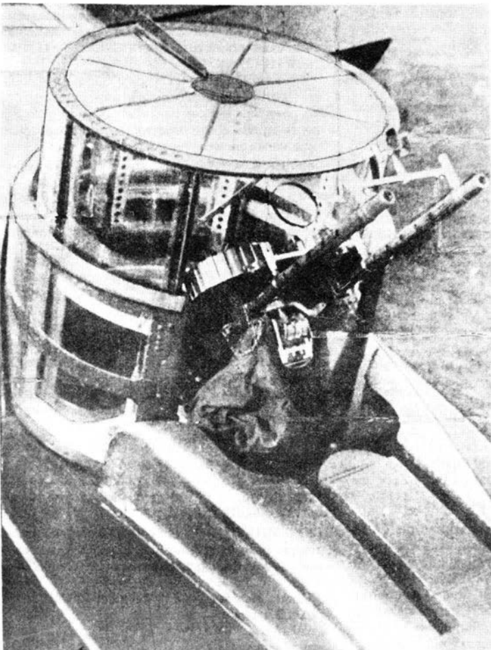
Rys. 10. Wysuwana wieżyczka strzelecka na górze tyłu kadłuba
