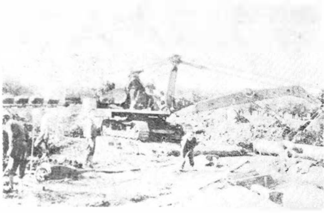
13. Koparka gąsienicowa na przedwojennej budowie. Zdjęcie ze zbiorów autora
