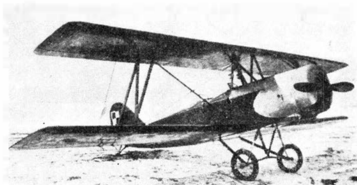
Rys. 5. Seryjny BM-4a po zmianie podwozia i modyfikacji usterzenia
