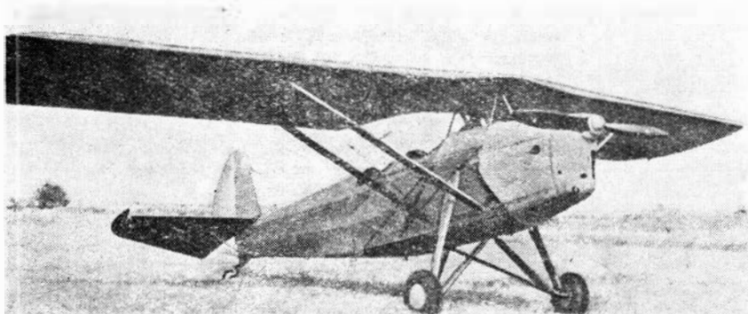
1. Prototyp RWD-17 podczas początkowej fazy prób, z małą powierzchnią wyważenia steru wysokości i ze sterem kierunku malowanym na biało
