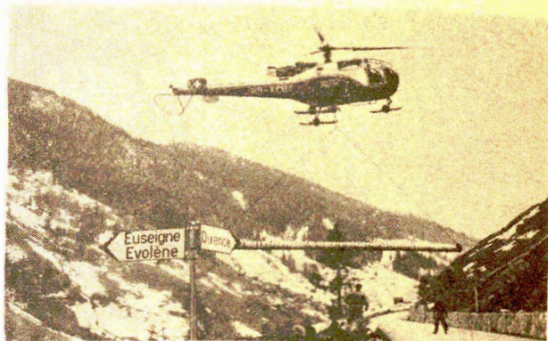
Budowa rurociągów w Alpach Szwajcarskich
