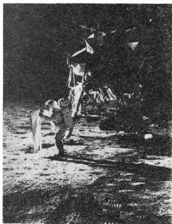
Edwin Aldrin ustawia na powierzchni Księżyca przyrząd — składający się z folii aluminiowej — który umożliwi zbadanie składu wiatru słonecznego (pod koniec pobytu astronautów na Księżycu folia została zwinięta i zabrana przez astronautów)
