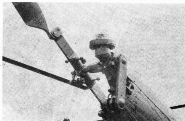
2. Głowica śmigła ogonowego śmigłowca „Scout” Fot. A. Glass
