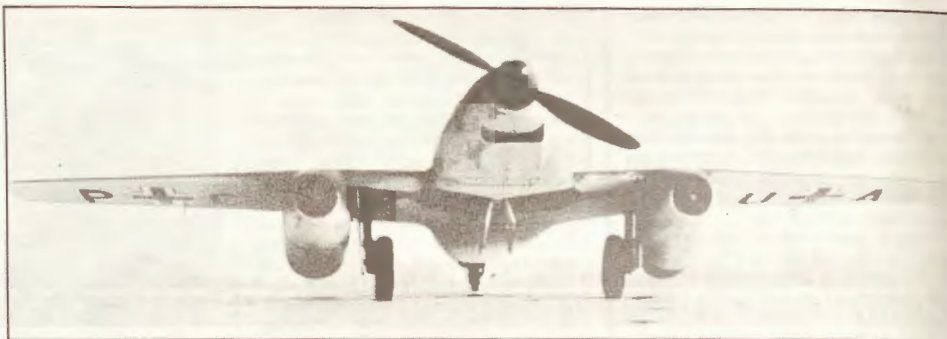
Me 262V1 (WkNr 262 000 0001) – druga modyfikacja po dodaniu silników odrzutowych BMW 003 do silnika tłokowego
