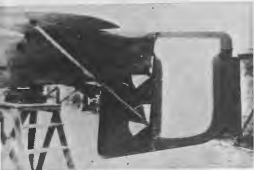
Opuszczane do dołu usterzenie pionowe w doświadczalnym R-XIII
