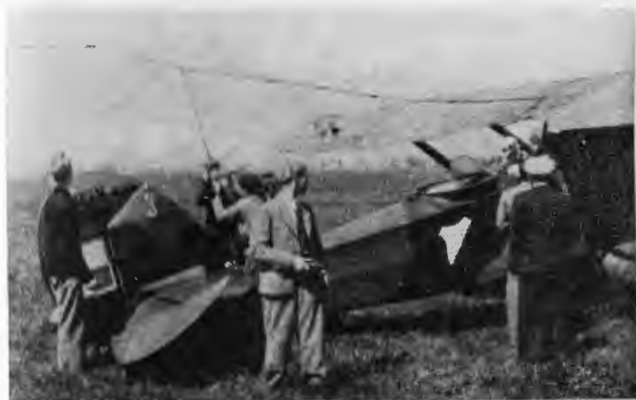
R-XIIIC nr 56-89 z Centralnej Eskadry Treningowej 1. pułku lotniczego w Warszawie, z urządzeniem do holowania szybowców. Samolot miał zdjętą obrotnicę k.m., dodany wiatrochron przed tylną kabiną i latał bez pierścienia Townenda
