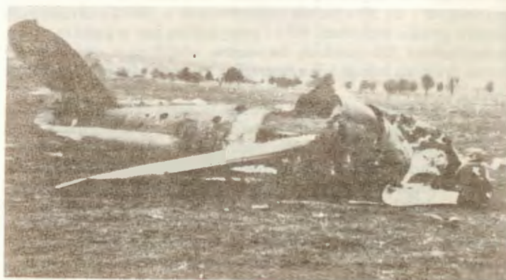
Rys. 18. Hs 126A zniszczony nad Polską (arch. J. B. Cynka)
