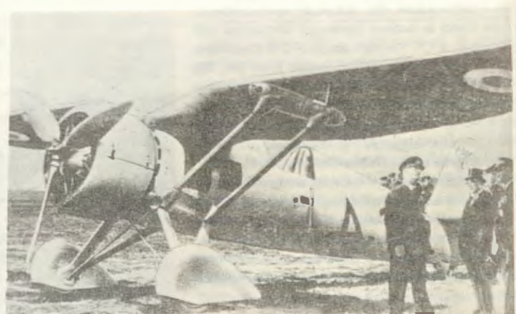
Sfałszowane w wytwórni zdjęcie tureckiego P.24C z domalowanymi działkami, chłodnicami, dzwignią sprężarki, greckim oznakowaniem i doklejonymi postaciami
