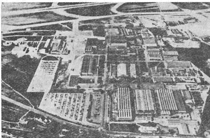
Rys. 5. Ogólny widok zakładów w Marignane pod Marsylią; na pierwszym planie hale obróbki mechanicznej i Samodzielnego Wydziału Szkoleniowo-Awaryjnego; na drugim planie hale obróbki cieplnej; w głębi hale montażu
