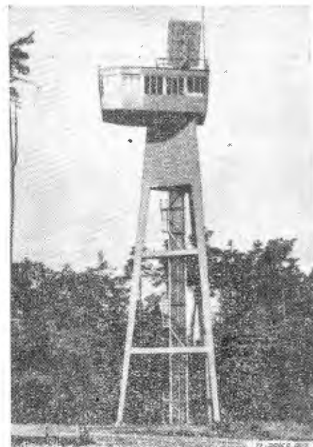
Rys. 62. Fotografia radiolokatora obserwacji okrężnej bliskiego zasięgu (strefa przylotniskowa) w porcie lotniczym Frankfurt
