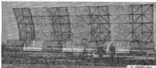
Rys. 64. Fotografia anteny radiolokatora obserwacji okrężnej Marconi S-264 w porcie lotniczym Fiumicino
