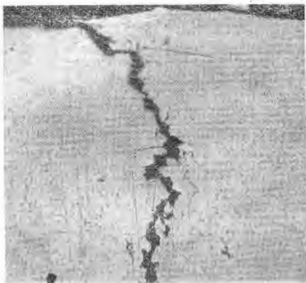
Rys. 8. Efekt działania kąpieli korozyjnej przez szczelinę pęknięcia zgrzeiny (szlif nie polerowany, pow. \times 300 )
