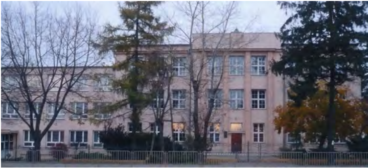
Ryc. 10. Fasada frontowa szkoły powszechnej w Jastkowie, fot. autor
