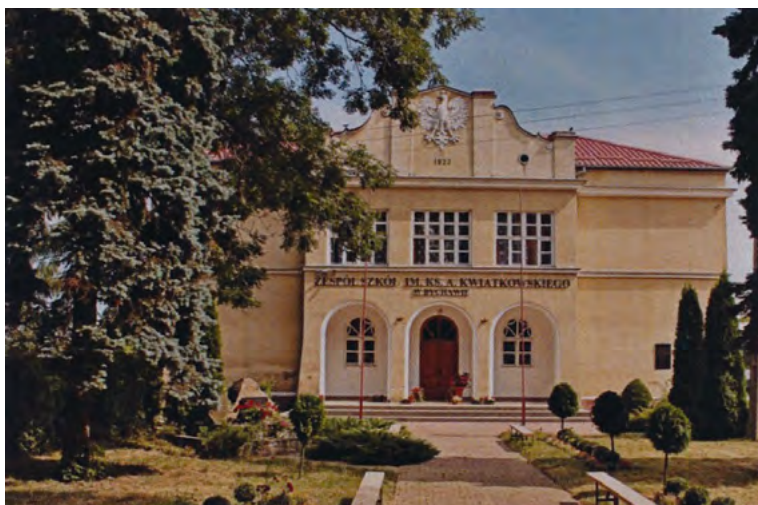
Ryc. 4. Widok elewacji frontowej szkoły powszechnej w Bychawie, fot. autor
