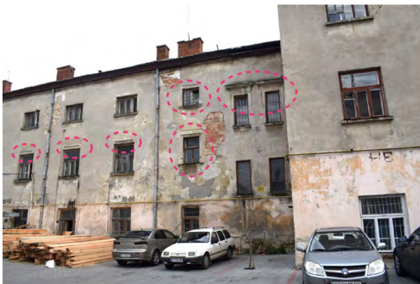
Ryc. 2. Fragment elewacji północnej zachowanego budynku cel klasztoru oo. Karmelitów Trzewickowych. Okna budynku zostały radykalnie przebudowane w XIX w. Linia przerywaną oznaczyliśmy autentyczne kamienne profilowane obramienia (dowód, że jest to obiekt z XVII wieku). Opracowanie: M. Bevz, 2022
